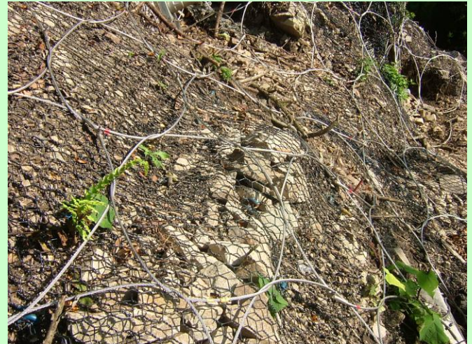
落石源はネット併用で固定
