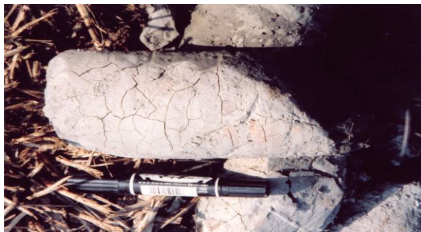
写真1 定着部泥岩（掘削2日後）
