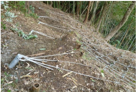
(同上, 岩塊周囲に打設した深層アンカー。人力施工)
