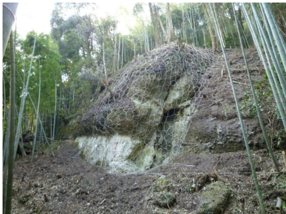
(斜面長 25m, 最大層厚 3.5m の岩塊を固定)
