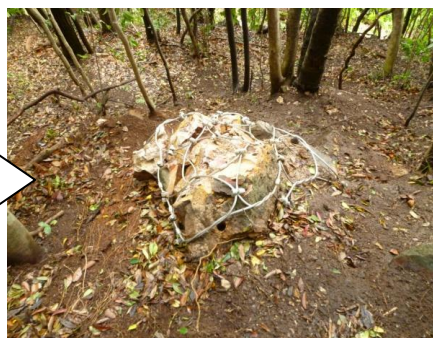
【クラッシュネット工法】 ...過酷かつ危険な搬出作業を回避するために開発 (不安定な石をワイヤーネットで巾着状に包み, 安定形状に小割整形後, そのまま残置. 不安な場合はアンカーピンや深層アンカーで地山に固定する. 特許第 4615203 号)
