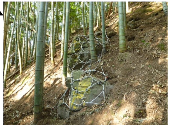
(複数の不安定な石を一体的に被覆し, 安定化せしめる)
