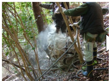
【クラッシュネット工法】 ...過酷かつ危険な搬出作業を回避するために開発 (不安定な石をワイヤーネットで巾着状に包み, 安定形状に小割整形後, そのまま残置. 不安な場合はアンカーピンや深層アンカーで地山に固定する. 特許第 4615203 号)
