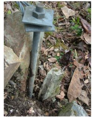
写真-7 岩用アンカーの剥離状況
