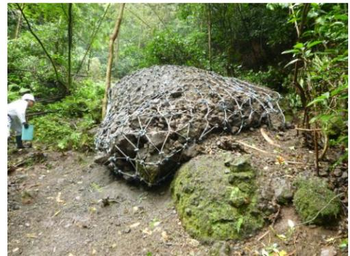
写真-2 ネットによる転石(φ3m)小割状況。緩斜面に乗り上げるような状態となったことから、この状態で滑動に対する安定度も確保できている。
