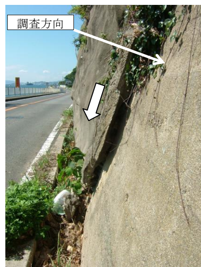
写真-2 同上、側壁部
