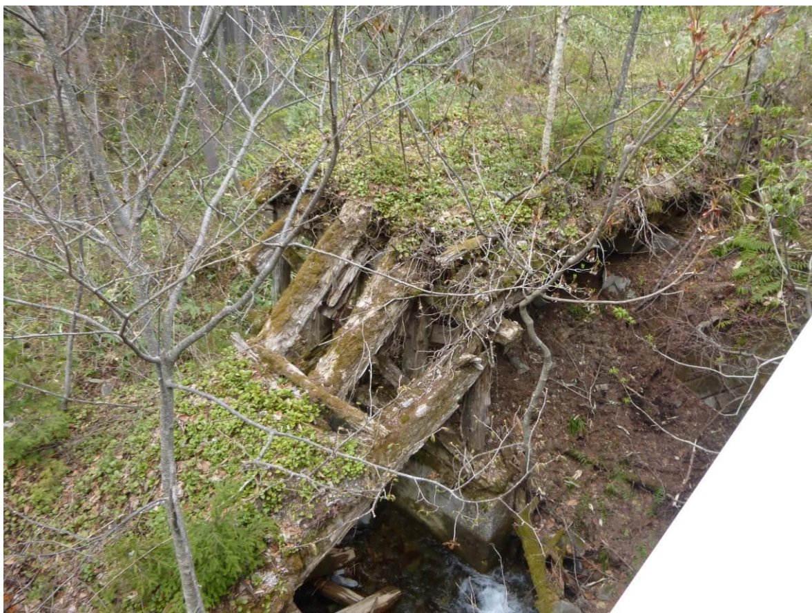
○木製橋の腐食
