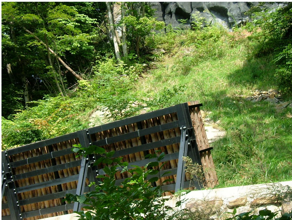
○落石防護柵（100kJ 程度）
