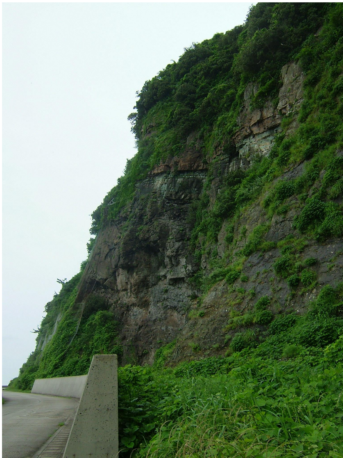
○コンクリート壁
