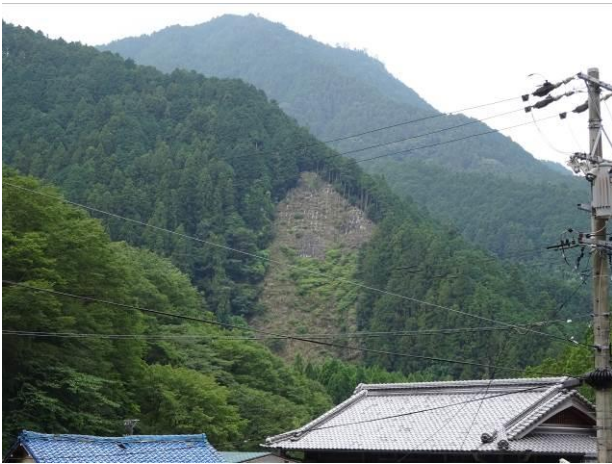
林地内の法枠
