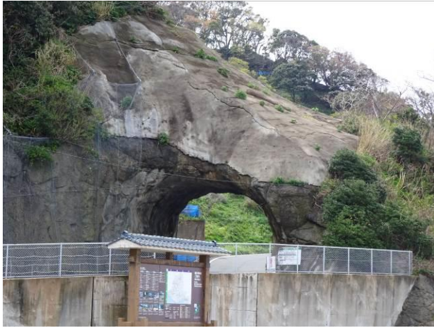
素堀トンネル
