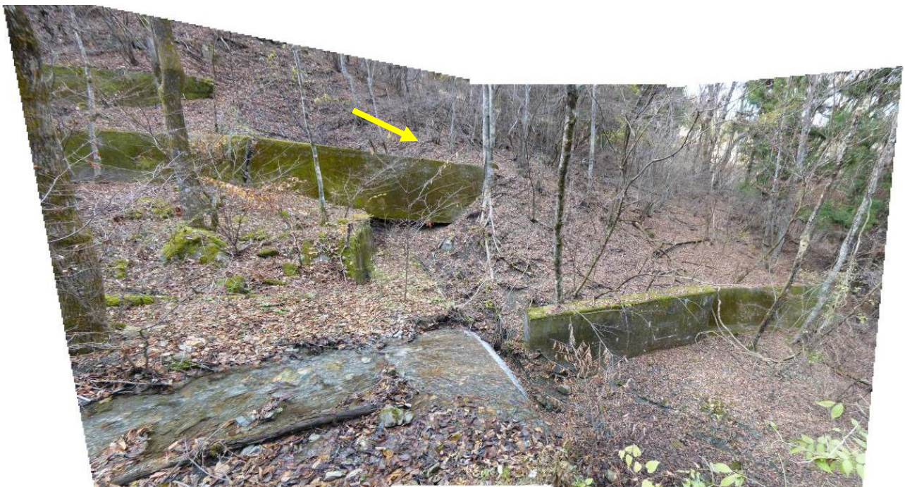
○左岸側地すべりによる変状
