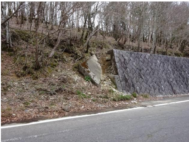
袖部の崩落（根入れ不足）
