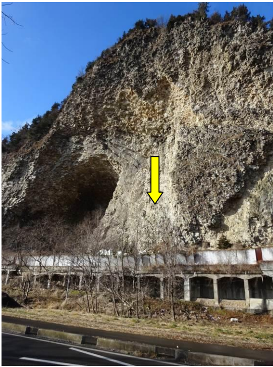
洞門の被災（岩盤崩落）
