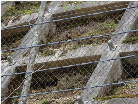
梁の位置で大きく浸食 （梁＝不連続面の形成＝地表水の誘導＝浸食助長） →梁の水抜き穴で解決？
