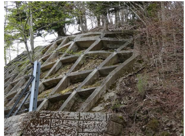
枠内の浸食（＝土砂流出）
