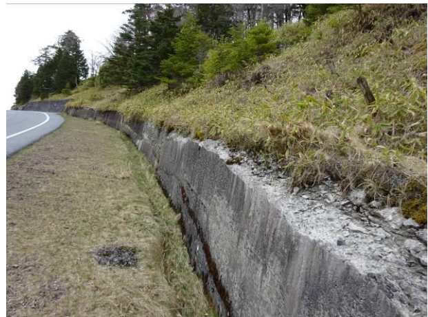
天端の損傷（施工不良による凍害？）
