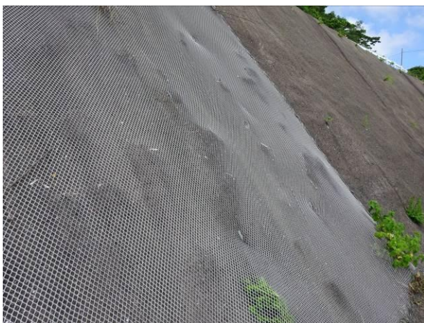
金網による補強例
