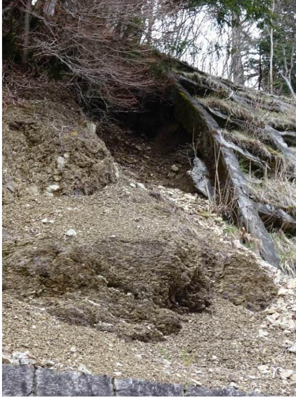
隣接斜面の浸食（枠内に貯留した水が浸透？）
