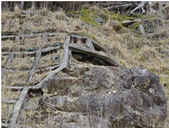
“法枠の基礎”に対する理解不足
