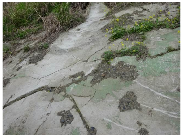
土砂部への吹き付け結果
