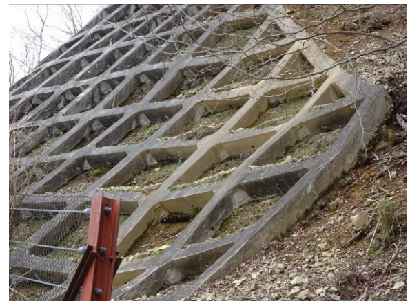
同左、水抜き穴1ヶ …目詰まりによる機能不全、穴の数量不足？ →改善策として、水切りモルタルの導入？
