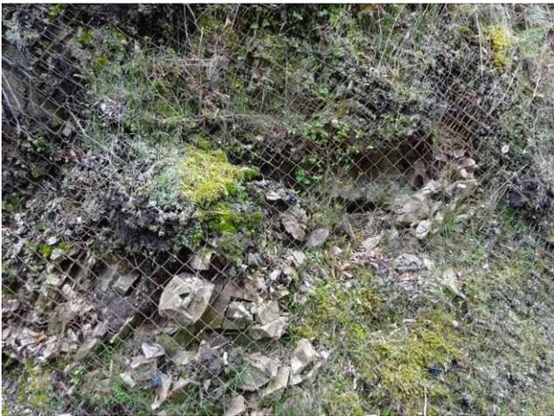
金網等による抑止（固定）力が不足するため、表土層の緩みが発生
