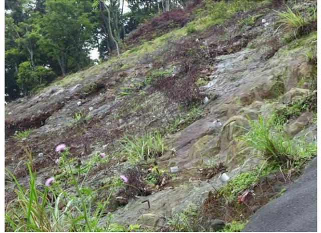
砂岩頁岩互層帯：金網（ $\phi 2\text{mm}$ 程度）が腐植し、緑化基盤を造成できていない
