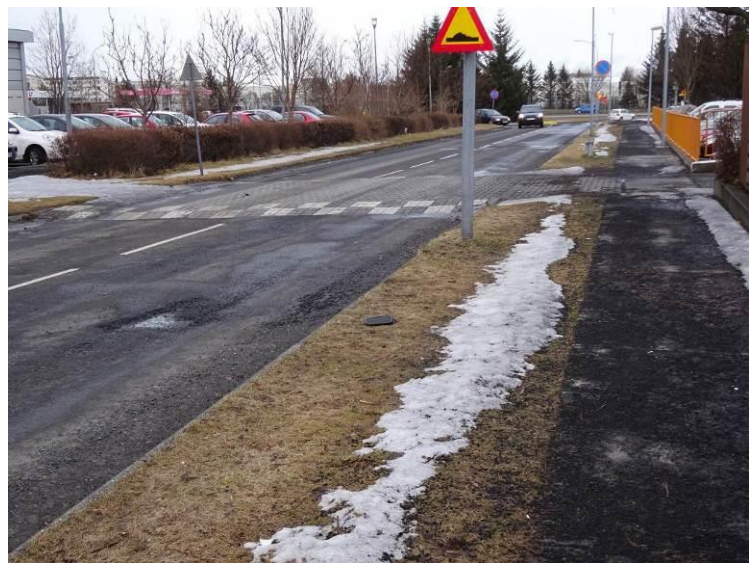
スパイクタイヤによる路面の損傷と 歩道の粉塵溜まり
