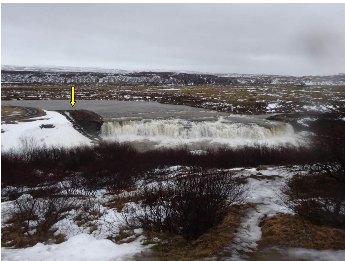
同上，下流側の滝に魚道を設置
