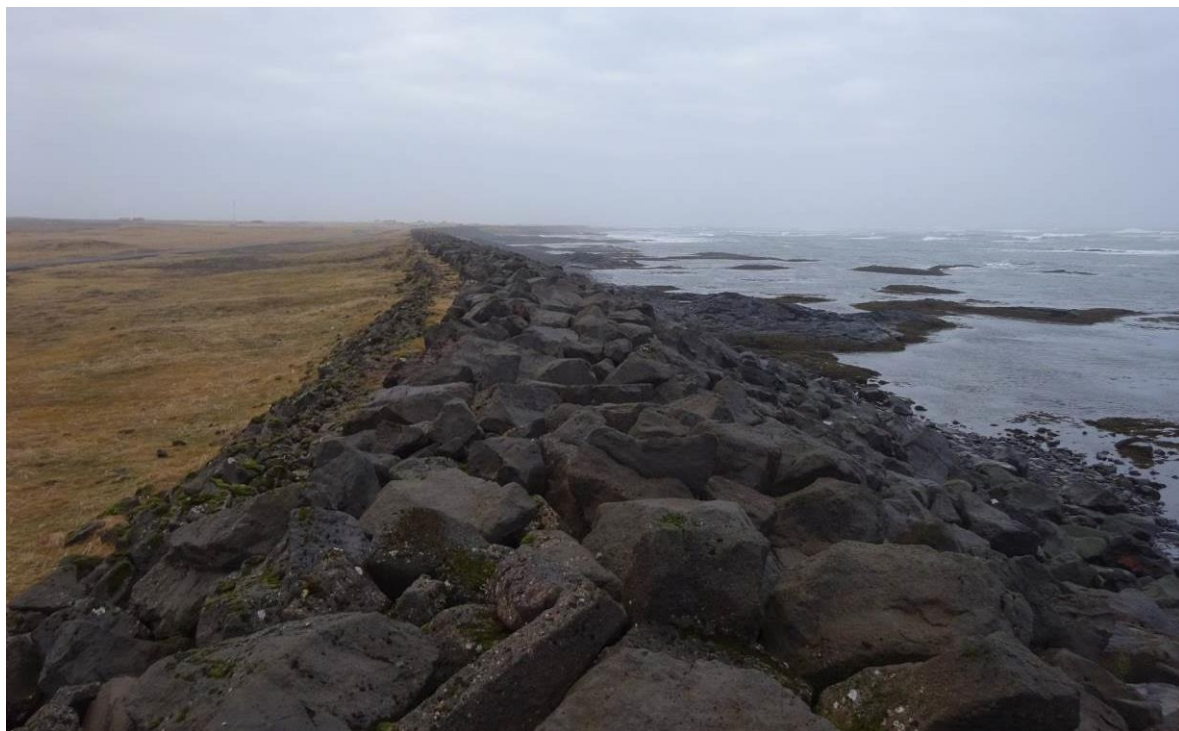
大西洋に面した石積みの護岸（溶岩上に構築：左の緑地も溶岩） ・・・日本の土木工事がいかに困難であるかが分かります
