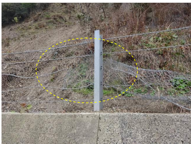
横ロープの破断
