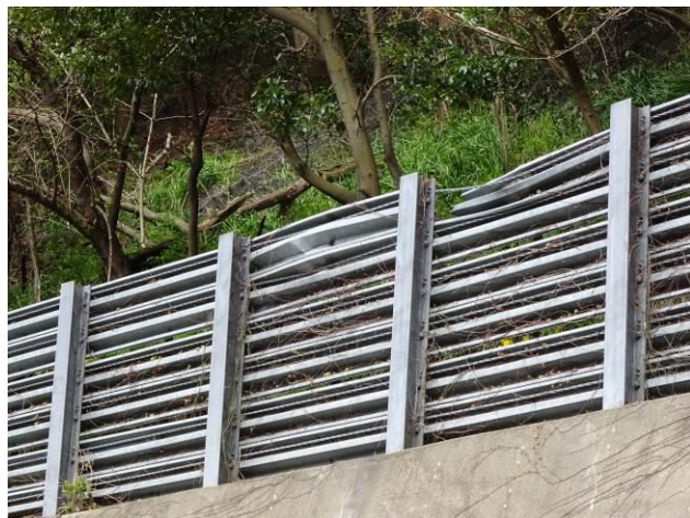
天端破損状況
