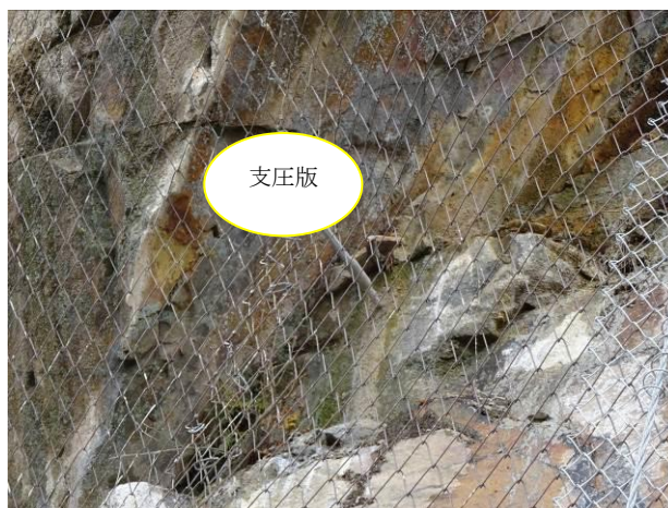
同左, 落石対策現場
