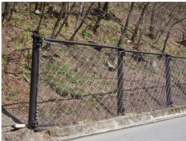
ワイヤーと金網の組み合わせ (ネット外周は可動状態)
