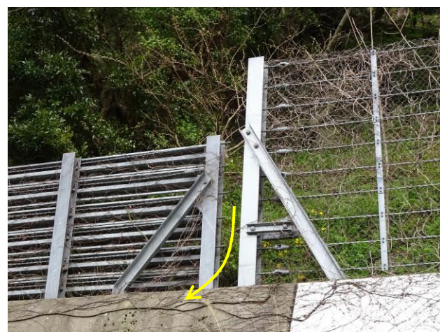
隙間からの転落事故が発生しており、柵は必ず重複させる必要がある。
