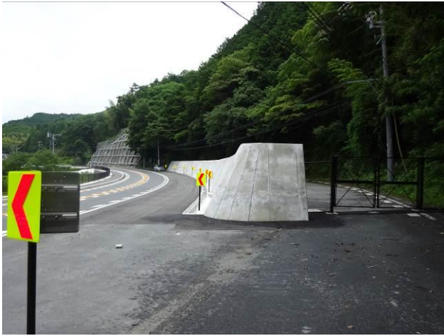
防護壁（土堤様式）・・・用地が確保できる場合の理想的工法 ・・・ステップに土砂等のクッション材を敷設すればさらに安全度が高まる
