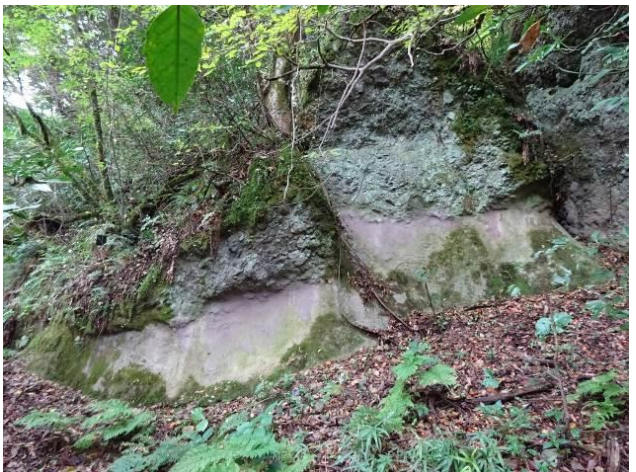
モルタル吹き付けによる根固（差し筋，金網等による剥離防止）
