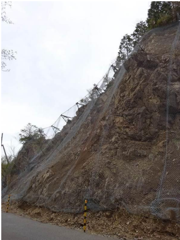
ポケット式の誤った利用方法 支柱は斜面頂部。密着状態でないため浸食が止まらない。 法面の浸食を直接防ぐ対策が必要！
