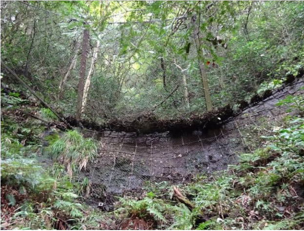
堆積土砂の管理が困難（人力作業）。崖錐が溜まりやすい斜面か否かの判断が必要、もしくは排土が容易な構造に改める・・・
