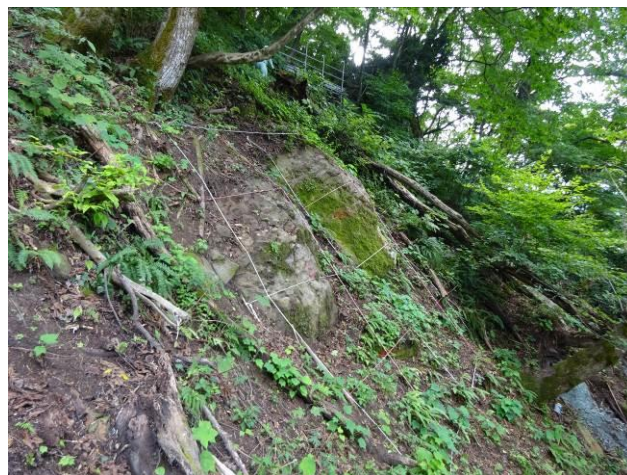
格子状ネット敷設前の割り付け作業 ・・・PPロープ敷設
