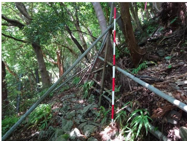
単管と金網による応急対策 (仮設)
