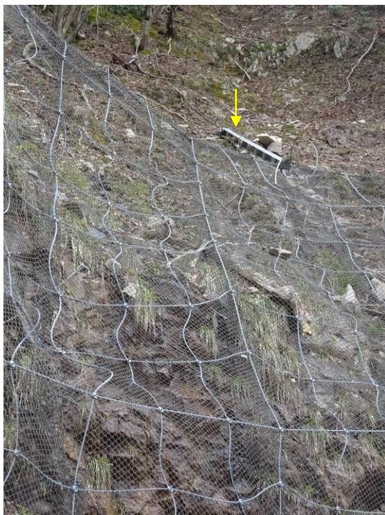
アンカーの抜け：…積雪荷重？
