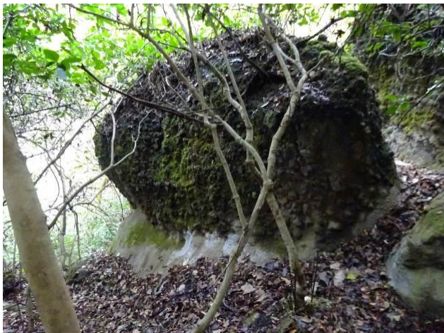
モルタル吹き付けによる根固（差し筋，金網等による剥離防止）
