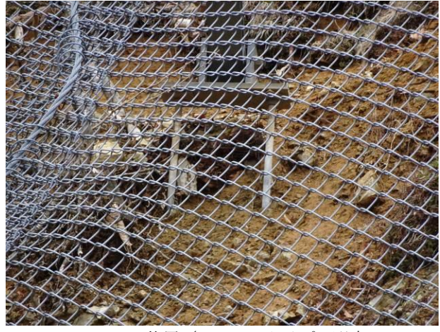
アンカー位置/アンカータイプの選定ミス
