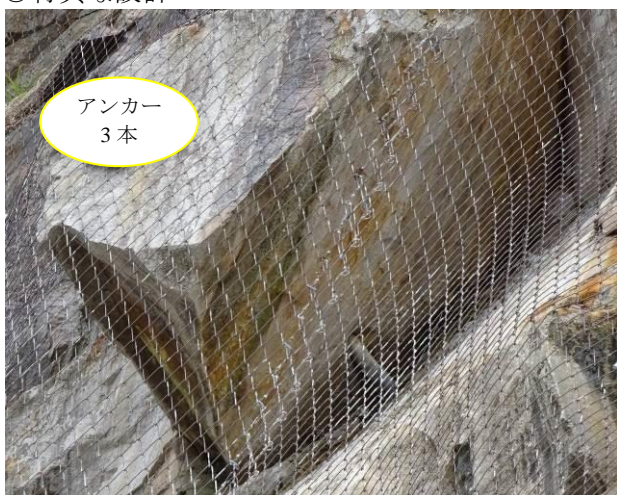
転落の危険性が高いと判定された岩塊を, 直接アンカーで固定した例
