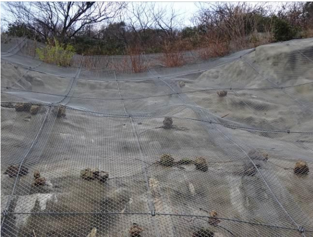
ポケット式による落石捕獲状況 →頭部斜面からの落石を捕獲（正しい利用方法）
