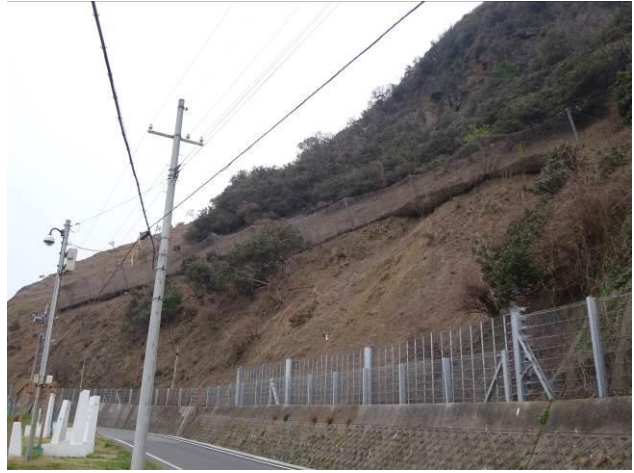
堆積土砂の管理が困難（人力作業）。崖錐が溜まりやすい斜面か否かの判断が必要、もしくは排土が容易な構造に改める・・・
