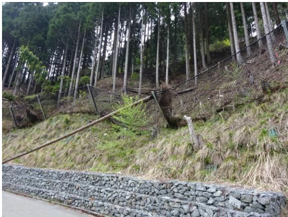
倒木による変形
