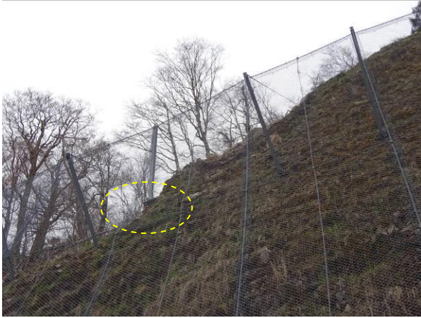
支柱アンカーの抜け
