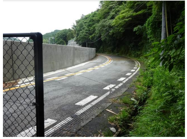
防護壁（土堤様式）・・・用地が確保できる場合の理想的工法 ・・・ステップに土砂等のクッション材を敷設すればさらに安全度が高まる
