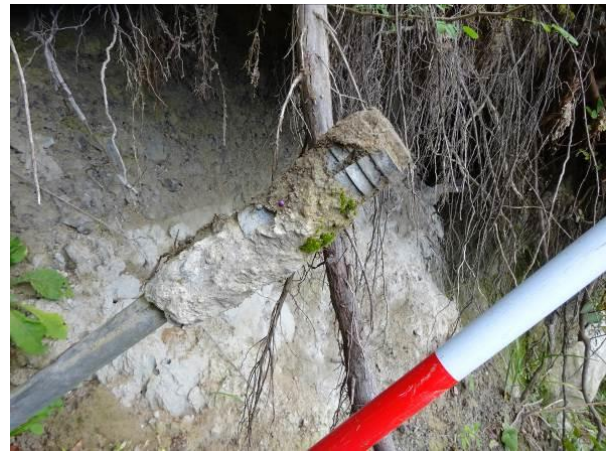
防護ネット用アンカーの引き抜け (先端圧縮型、泥岩地盤)
