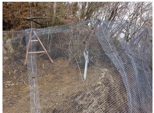
支柱の位置とアンカータイプの選定ミス？
