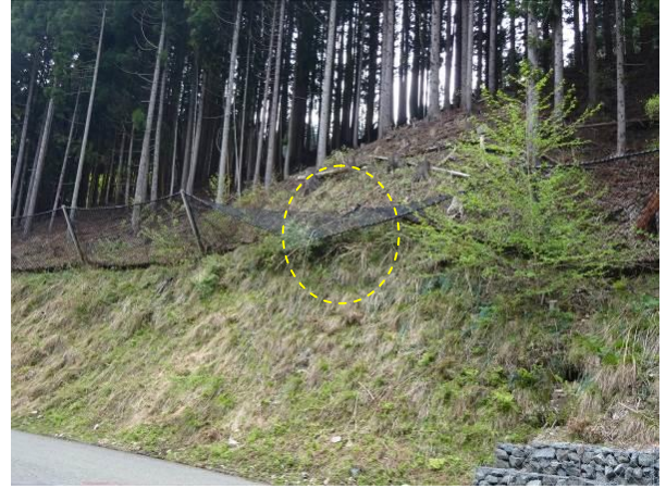
アンカーの抜け（積雪？）
