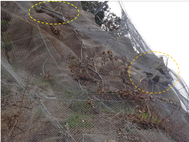
落石による支柱アンカーの抜け
