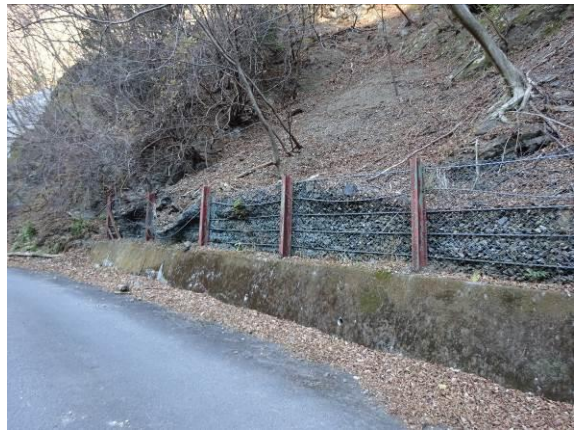
崖錐堆積による破損
