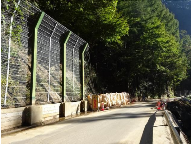
崩壊による破損
