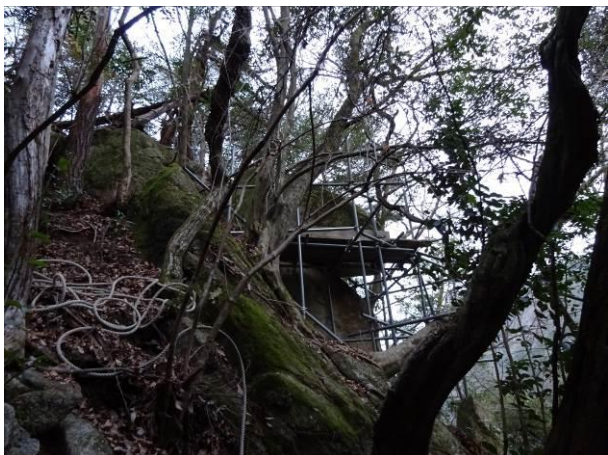
小割り除去のための足場仮設例 ……適正な足場仮設が計上されていない, 不良設計が多いのでは
