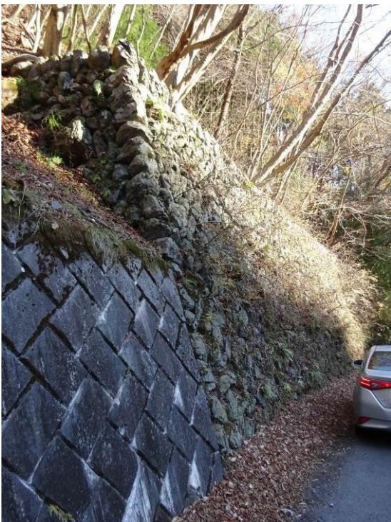
空石積み（高さ 5m）
