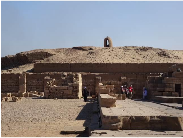
遺跡を守るための外壁（日干し煉瓦で構築） 外壁頭部の小ドームは監視小屋
