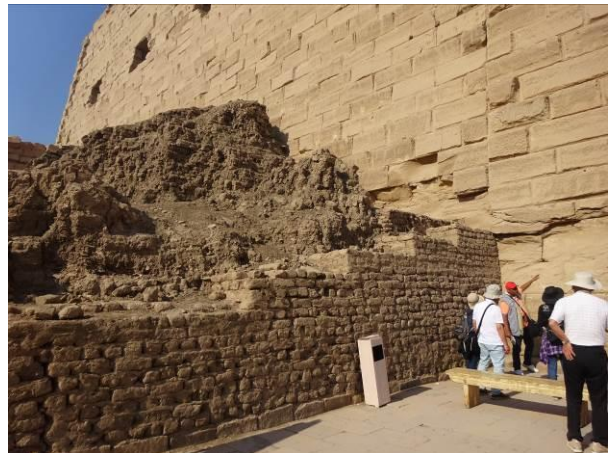
神殿の構築方法：写真のように積み上げた日干し煉瓦を利用して組み立てた模様。ここではなぜか後片付けができていないか、建築途中であったか……
