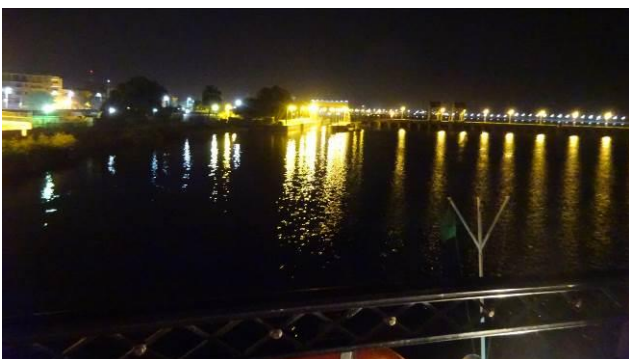
エスナ水門 (明るい位置. 水位調節用, 落差 6m) 通過. 水圧を利用するためか, 水門からの漏水はなかった.
