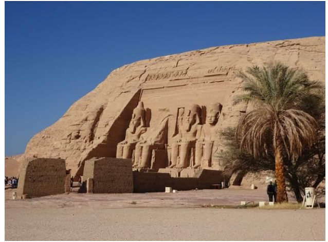
アスワンハイダムによる埋没を避けるため、湖面位置から60m程度上部斜面に移設（写真全体が人工物）
