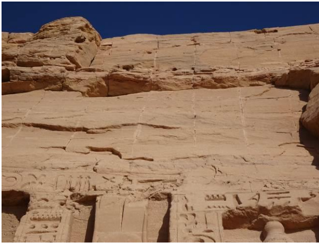
全体をのこぎり（人力）で分割，移動させるというスウェーデンチームの案により完成（ブロック状に切断した跡が認められる）
