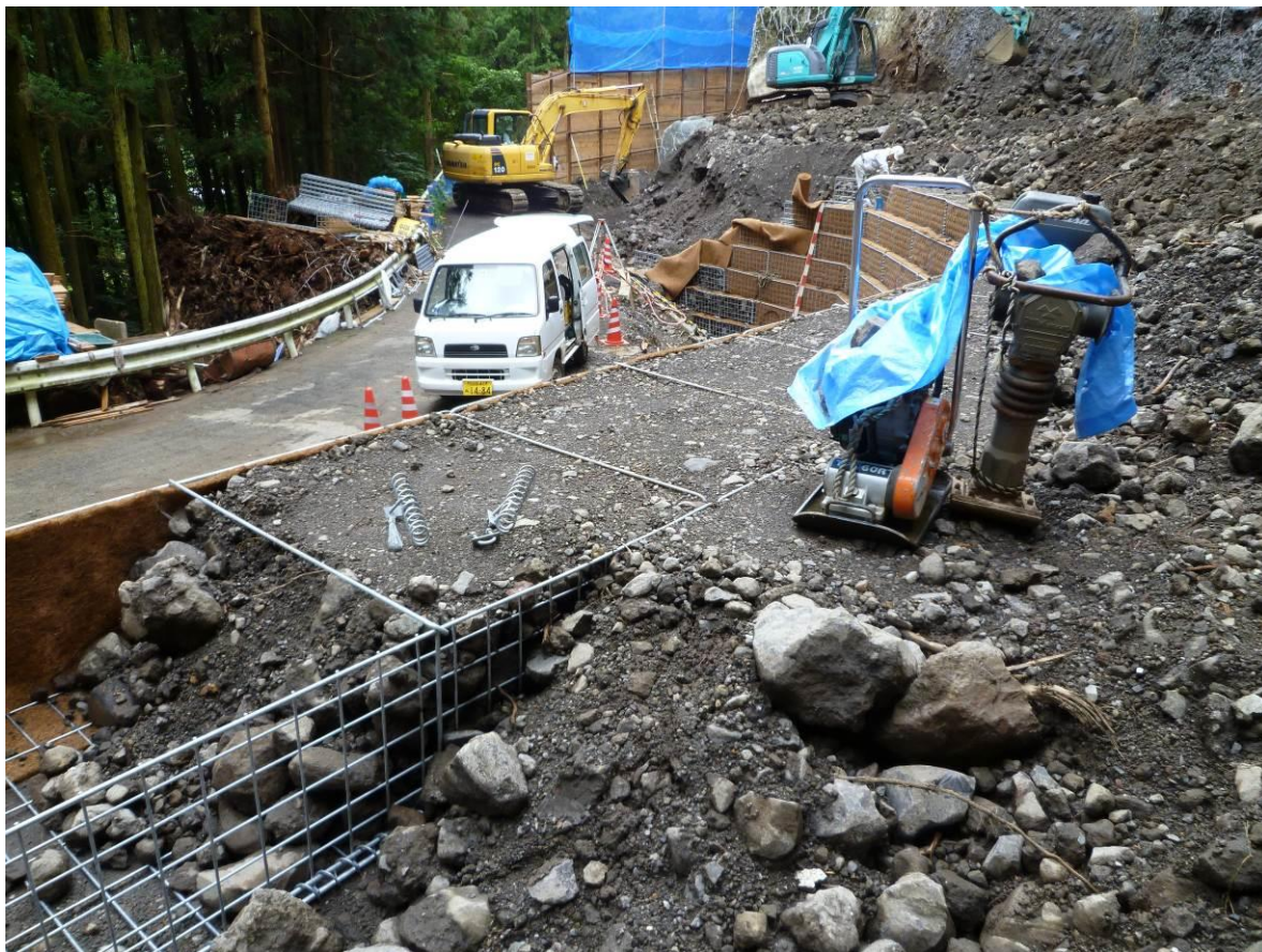
○かご枠（現地発生材利用）
