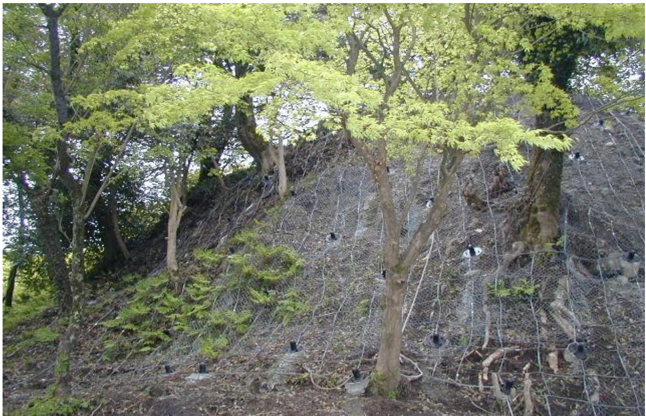
○鉄筋挿入工とワイヤーネットによる補強
