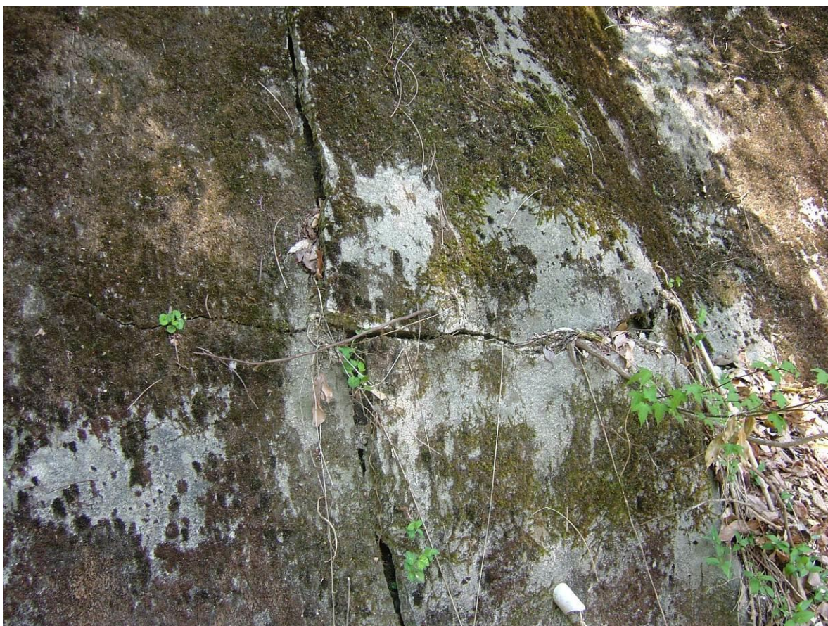
○モルタル吹付
