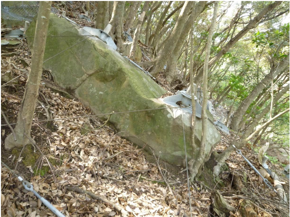
○鉄筋挿入工とワイヤーネットによる補強
