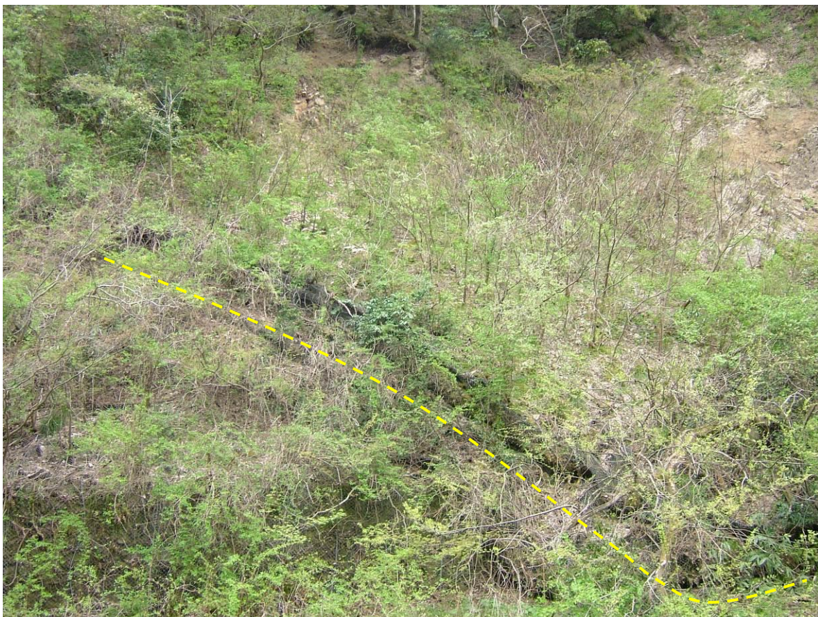
○表層崩壊により巻き取られた状態
