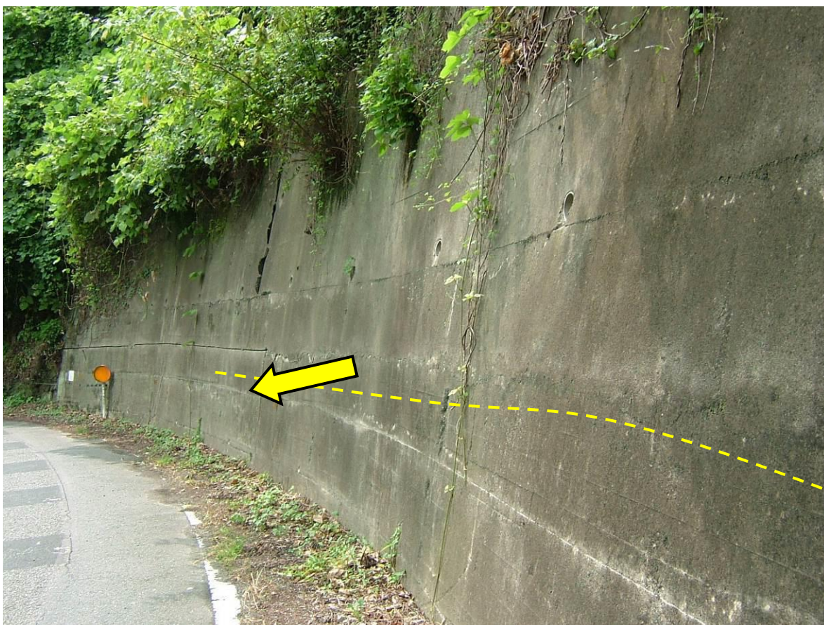
○コンクリート壁・・・地すべり土圧（末端部）によるクラック（折れ曲がり）
