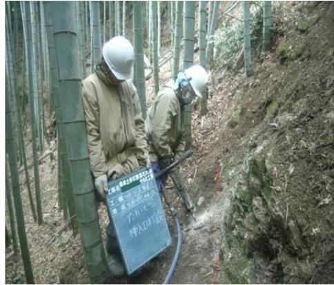
写真-5.1.4 アンカーピン設置孔穿孔状況
