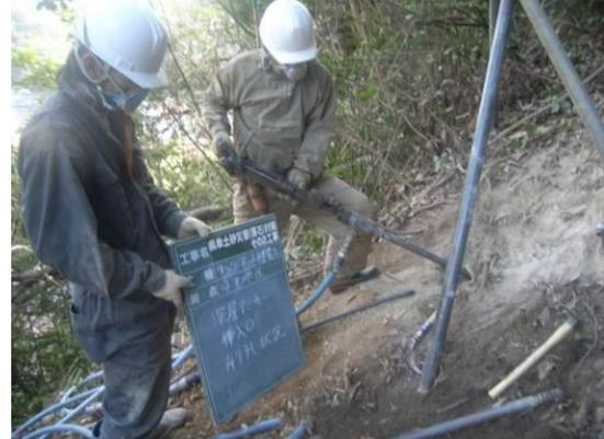
写真-5.1.5 深層アンカー穿孔状況
