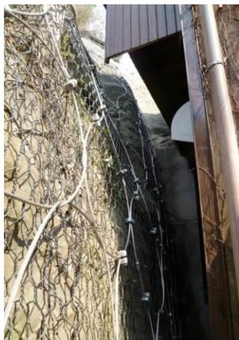
写真-5.1.2 樹脂製亀甲網併用例
