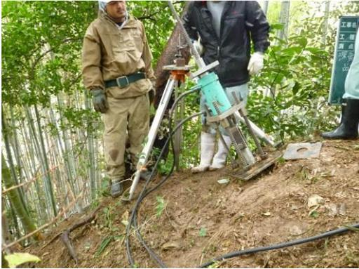
写真-7.1.1 深層アンカー基本調査試験
