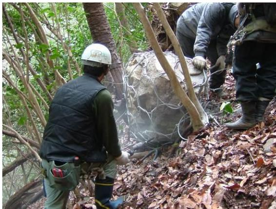
写真-5.3.2 アンカーピンの穿孔状況
