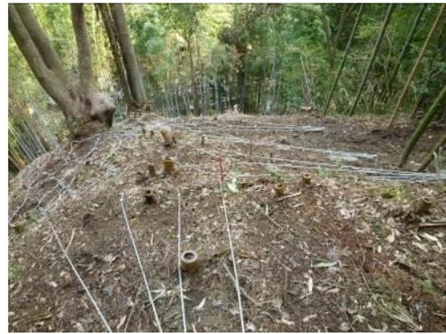
写真-5.1.8 深層アンカーによるワイヤーネット端部固定状況
