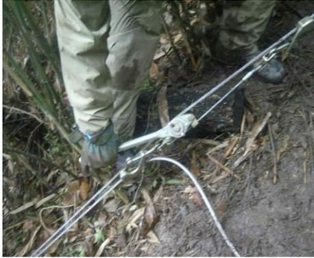
写真-5.1.7 補助ワイヤーの緊張作業
