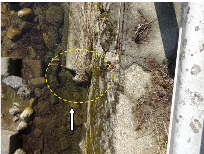
護岸の突起物（円内）位置で、背面の浸食を招いている
