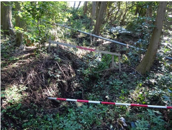
熊本地震（2016年）：丘陵肩部（緩斜面）の開口クラック
