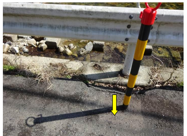
護岸の突起物（円内）位置で、背面の浸食を招いている
