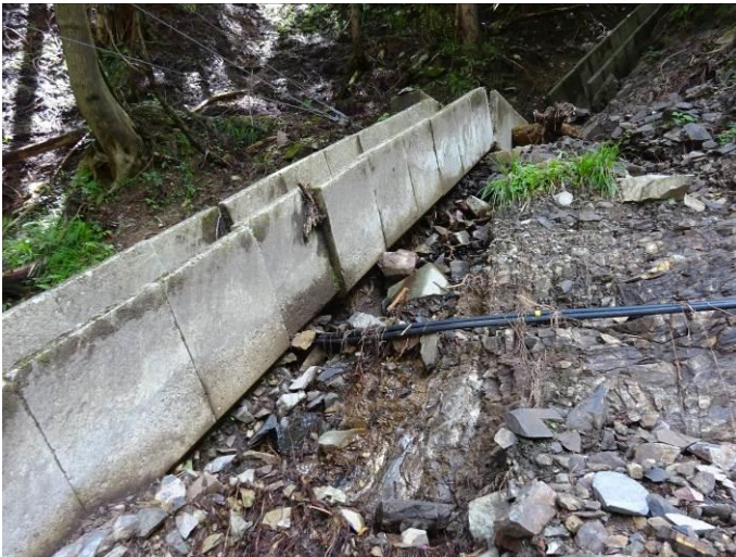
地山とのなじみが悪く、底部から浸食 森林内や急斜面では、土水路状に掘削した後、 “モルタル張付水路”といった構造が適当では？
