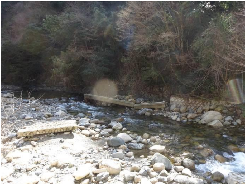
安易？な護岸(壁背面を伝った水圧？などで倒壊)
