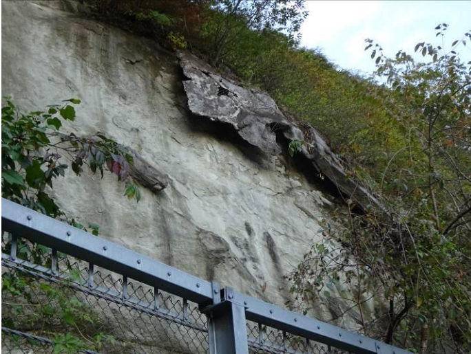
吹付法面脚部の浸食
