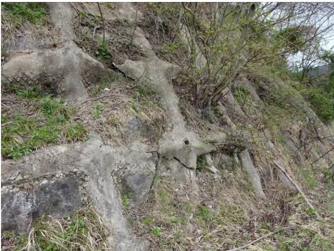
簡易法枠の根系による破断
