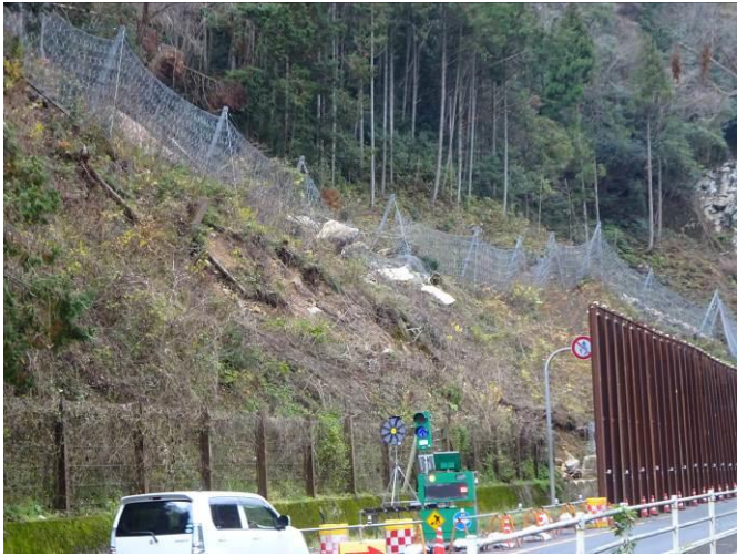
複数岩塊による防護柵の破損（発生源の面的固定が必要）
