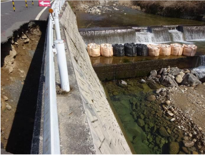
護岸の被災箇所=切り箇所（継ぎ目）からの浸水による吸い出し（弱点）
