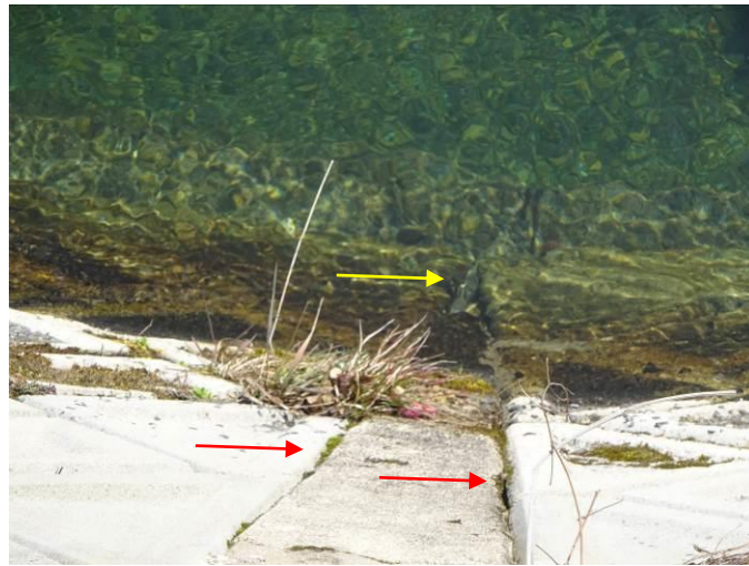
この程度の間隙箇所での吸い出しが多発
