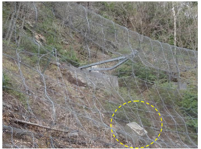
四角いコンクリート塊は支柱用アンカー？
