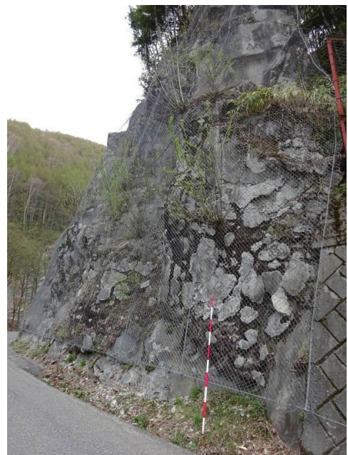
剥離した吹付け材を防護ネットで覆う
