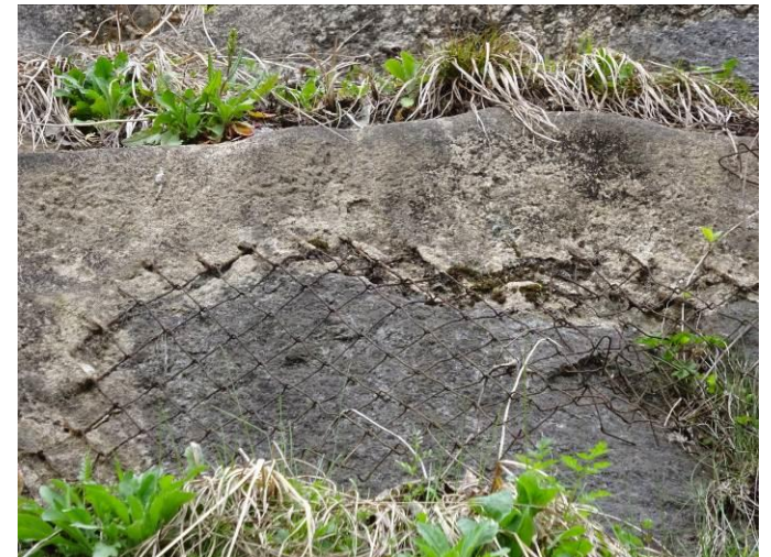
モルタルの剥離（被り厚が薄く，金網の腐食を助長）
