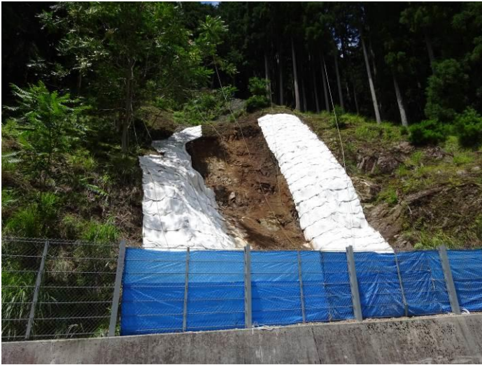
蛇紋岩地帯の旧地すべり斜面→末端部再崩壊→復旧→再被災
