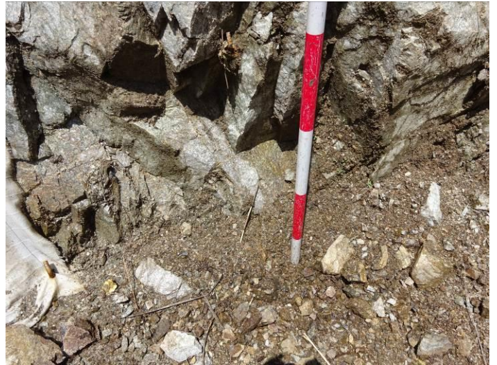
同左，流れ盤，湧水あり 緑化材固定用アンカー（15～20cm/本）6本/m 2 が、 地山を緩めた可能性？
