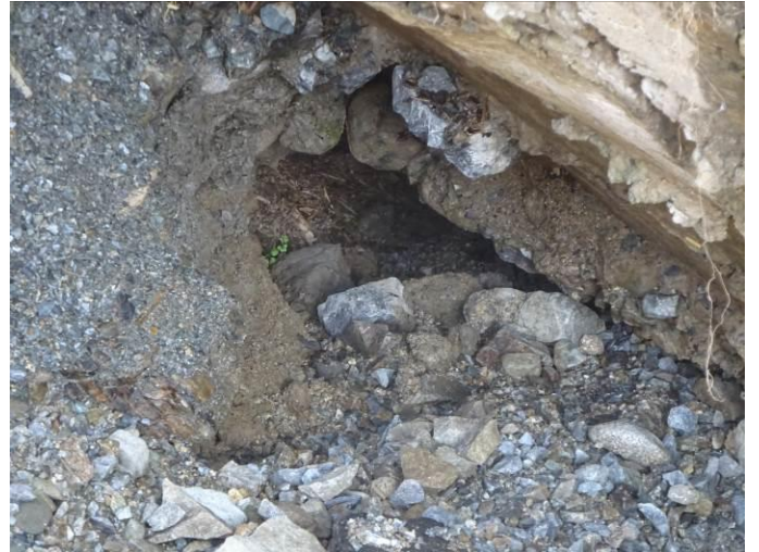
護岸の被災箇所=切り箇所（継ぎ目）からの浸水による吸い出し（弱点）
