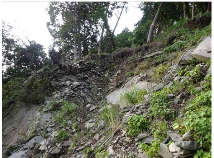
同左，斜面全域にわたる変状
