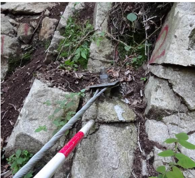
アンカーを鉛直方向に設置したことによる頭部の剥離
