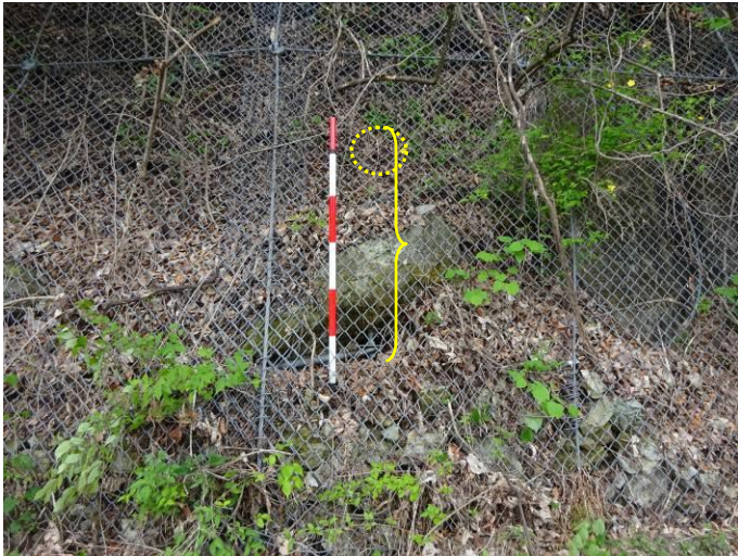
岩用アンカー（長さ1m）の引き抜け
