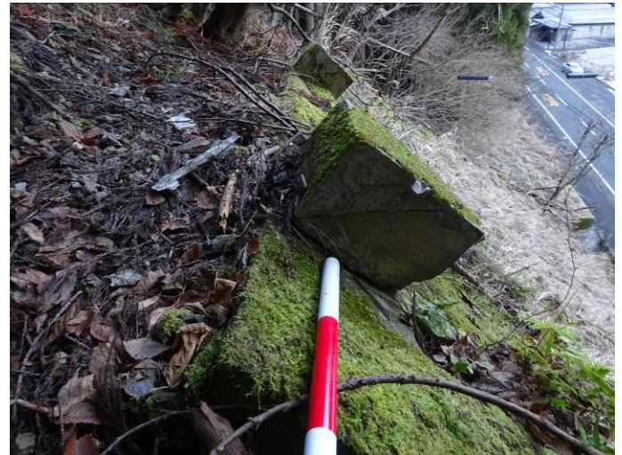
キャッピングの剥離=アンカーの抜け
