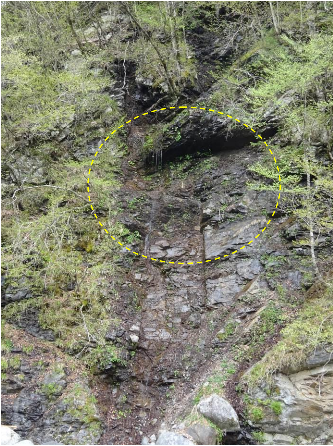
湧水箇所での浸食状況
