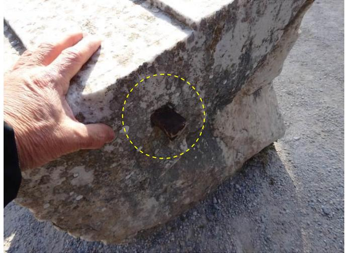
積み重ねた石材を連結する孔(左写真). 右は孔に差し込んだ連結材（鉄：円内），隙間には鉛を充填.
