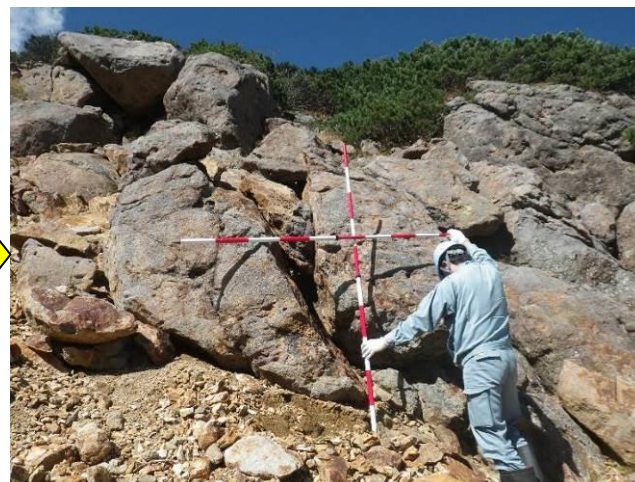
積雪地帯 (2年後の変状)
