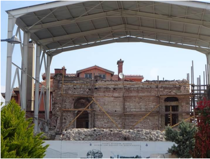
時折中途半端な建物（建築途中）を見かけるが、税金逃れのため、未完成に見せかけているとのこと
