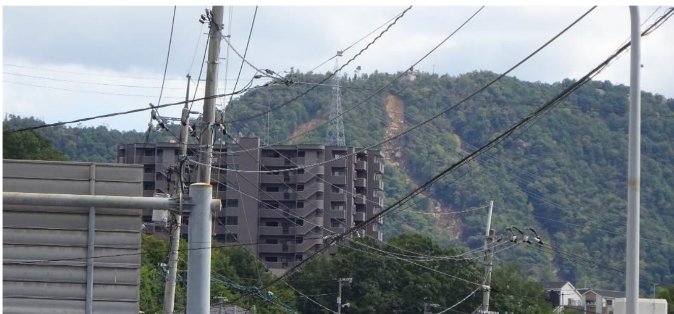
土石流（2018年、広島県熊野町）
