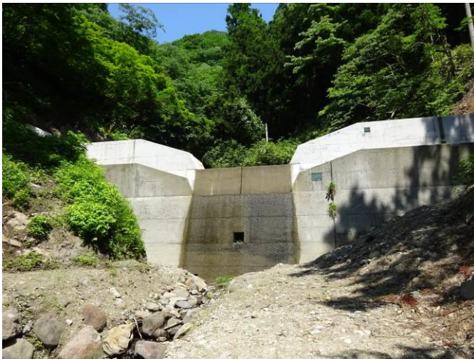
既設堰堤の嵩上げ
