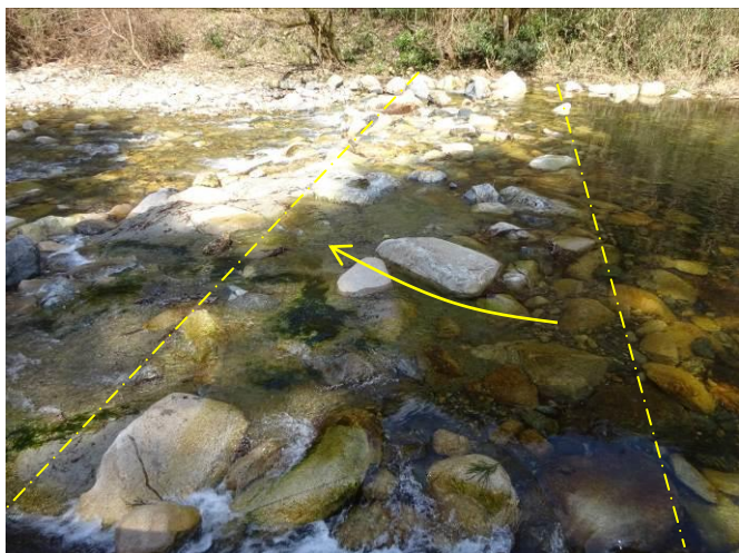
河床の巨礫を利用した床固め（写真右は上流側、真庭市）
