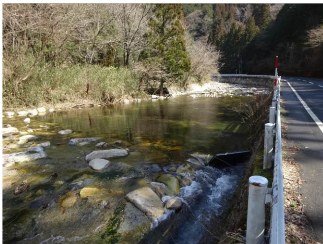
河床の巨礫を利用した床固め（写真右は上流側、真庭市）
