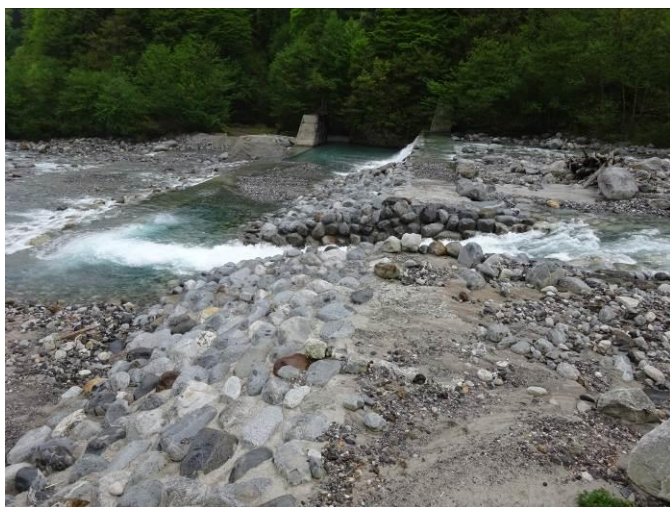
床固工 (表面は自然石で修景)
