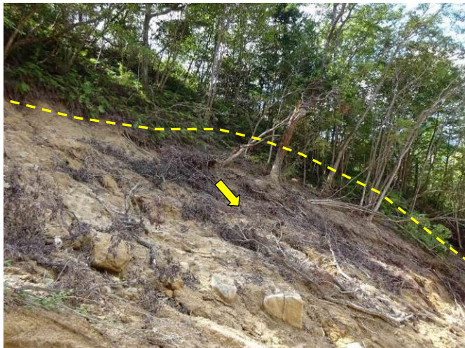
溪岸沿いの表層崩壊
