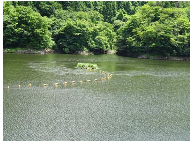
ダム浄化装置
