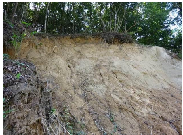
道路法面肩部（遷急点）の表層崩壊
