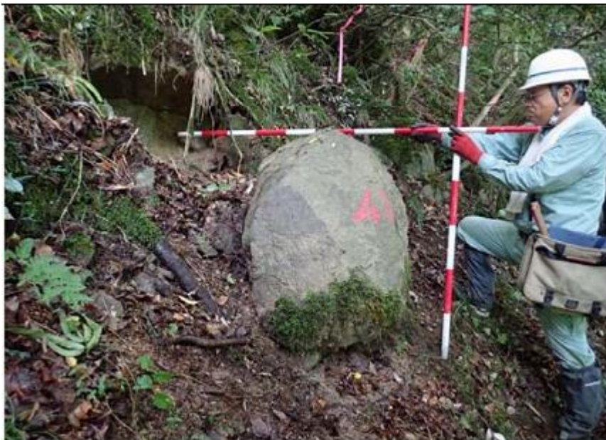
半埋没状の岩塊が飛び出した状況
