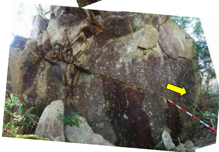
剥離面 A からの湧水，上位岩塊のすべり方向
