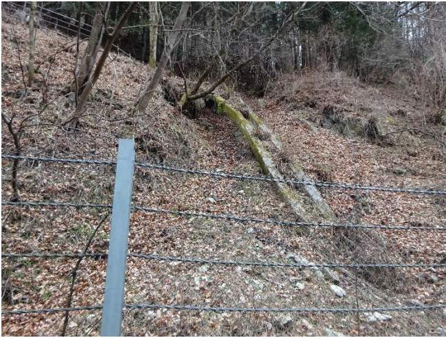
構造物と地山の“なじみ不良”による浸食
