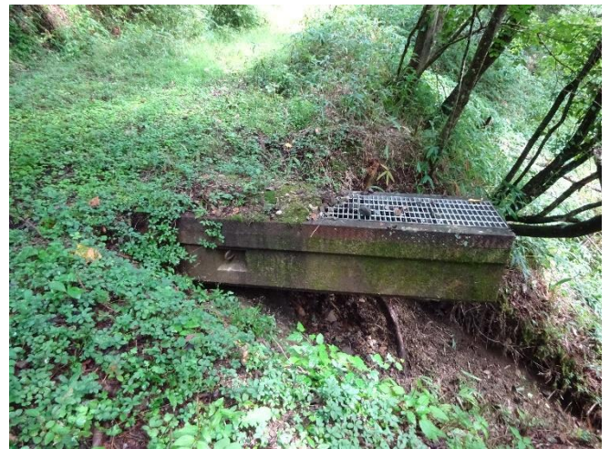
構造物と地山の“なじみ不良”による浸食
