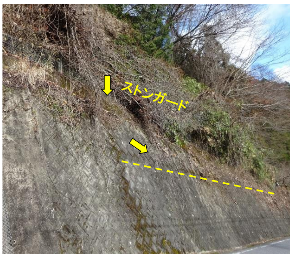
乗載荷重によるブロック積み擁壁の座屈
