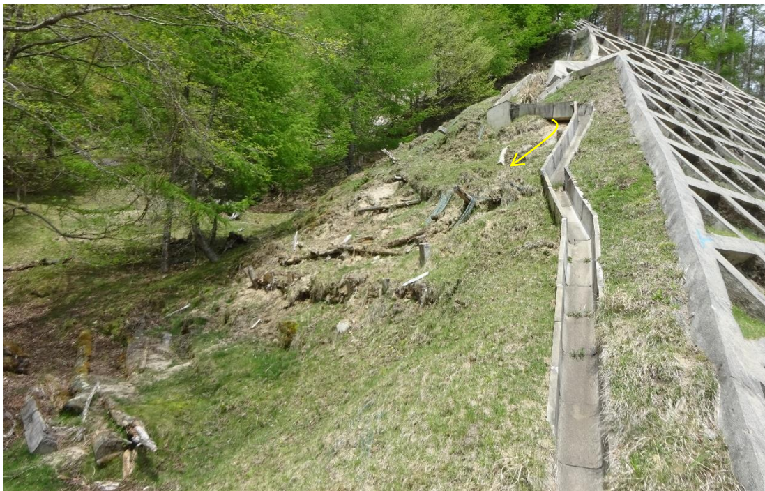
水路底面からの伏流水と木柵の腐朽による変状 ※木柵の計画：腐朽するまでに、立木が成長（根系で表層土を固定）することを想定
