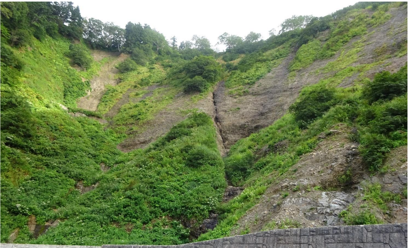
【崩壊面】・・・白山周辺
