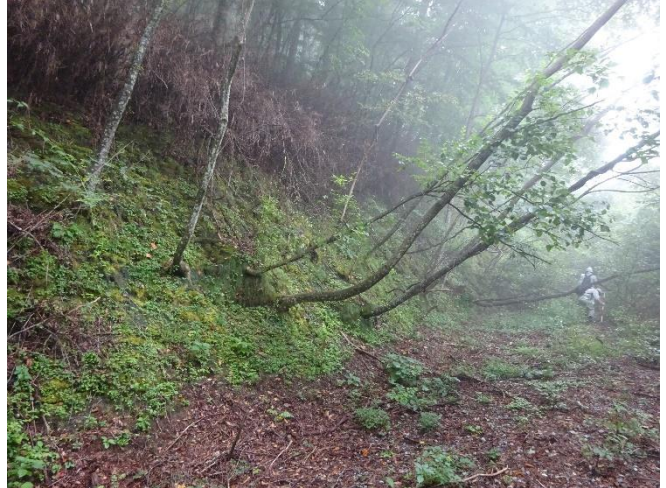
林道法面の倒木 管理しない立木は崩壊等を助長する・・・
