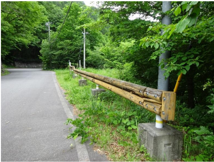
○木製ガードレール
