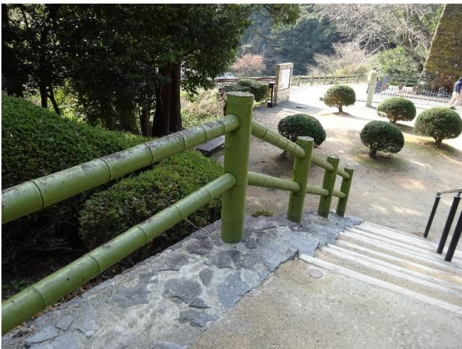
擬竹の手すり
