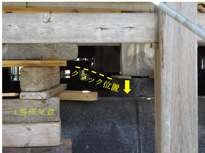
②本殿基礎中央付近の沈下（1～2cm）
