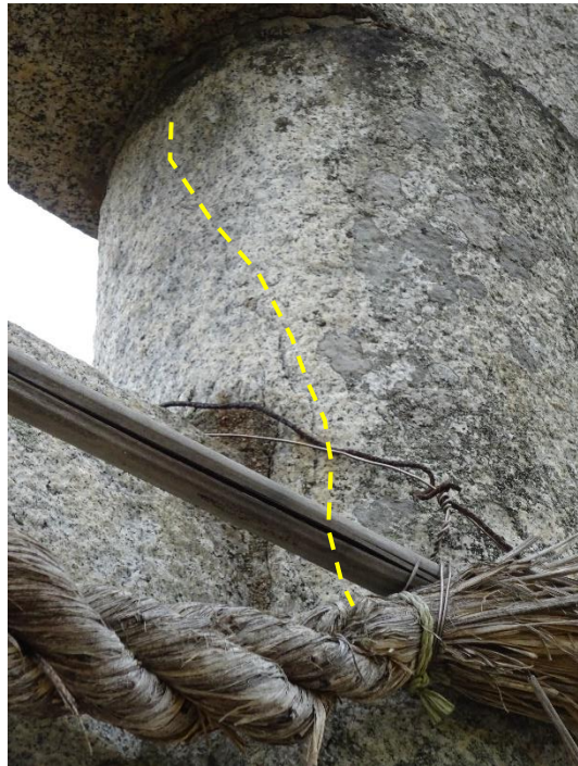
貫付近の柱のクラック
