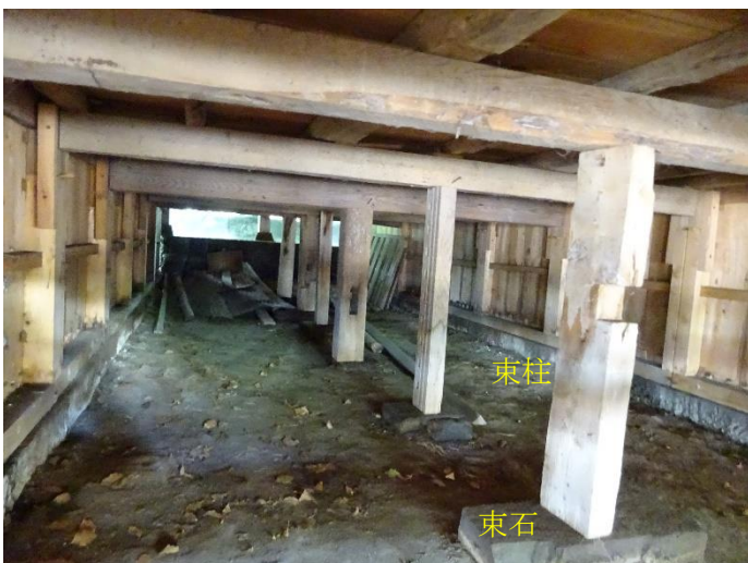
④中殿床下を支える束柱と束石
