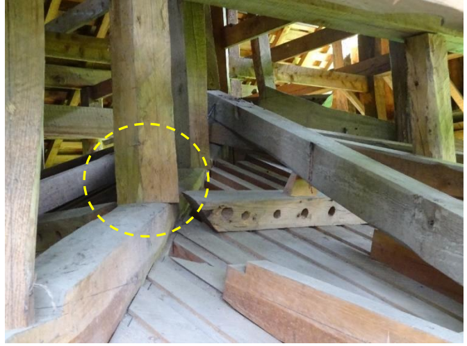
⑦下位の寄棟造（頑丈そうに見える） ※穴あき材は古材（強度設計外）
