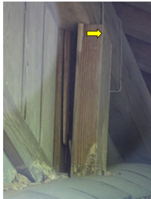
⑭中殿と拝殿を境する柱の剥離
