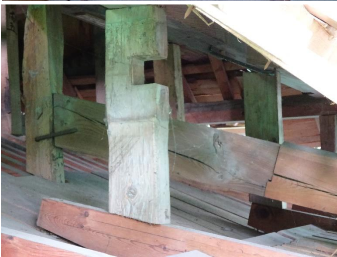
⑨古材を用いた東柱 ※あり合わせの古材を使う習わしがあるとのこと …それにしても頼りなく見える
