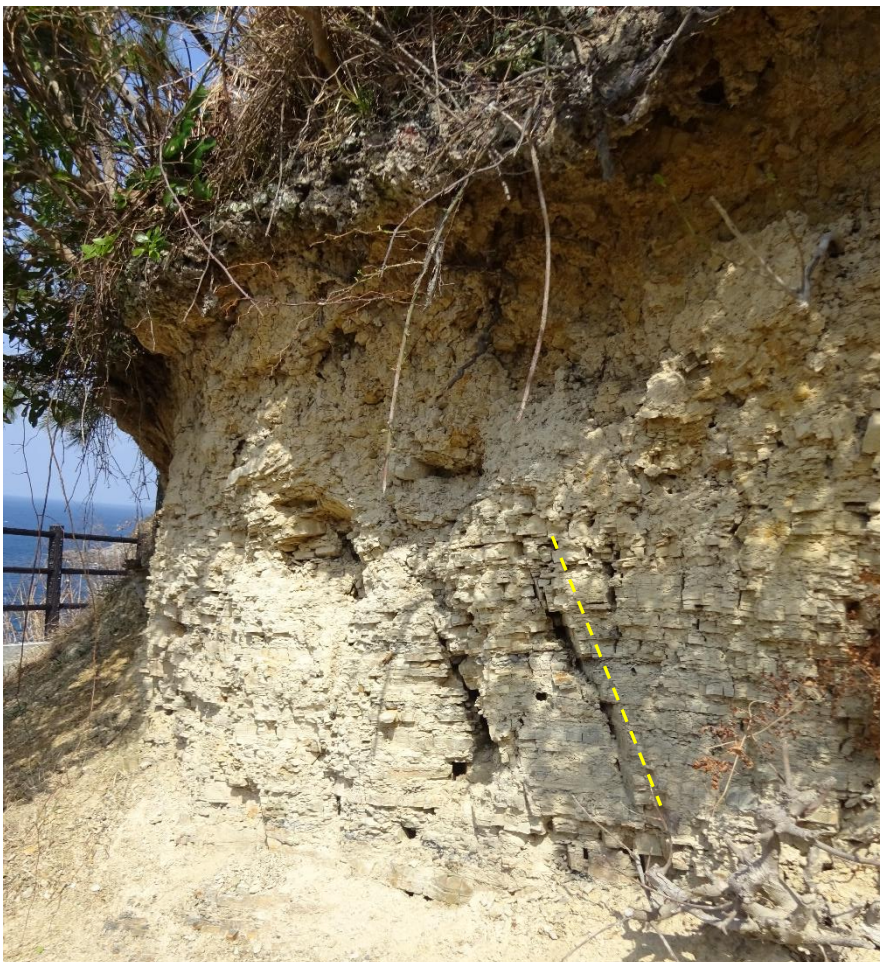
同上, 山腹における地層内の空隙
