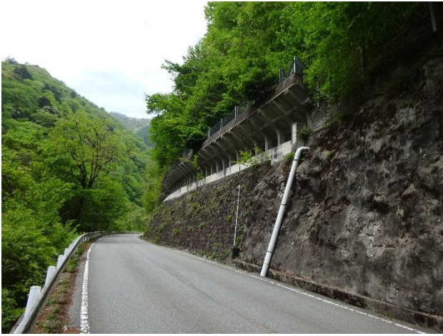
○法肩の防護柵
