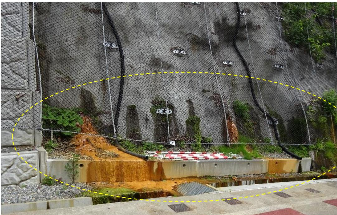
地下水の堰き止め：補強材による抑止力を相殺しかねない…
