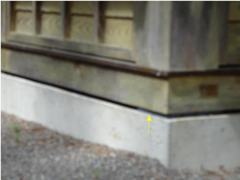
コンクリート基礎の上面に、厚さ 1cm 程度のなめらかな鉄板（15cm 角程度）をかませ、地震力の低減を図っている（ピンボケ…）
