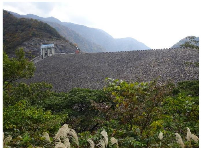
国内最大級のロックフィルダム（石川県手取川ダム：高さ 153m）
