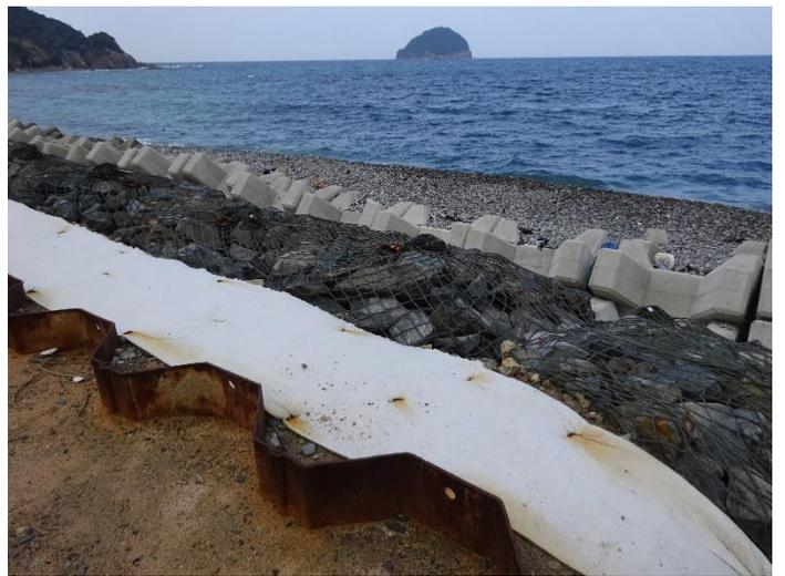
護岸復旧？（日本海）・・・網矢板，吸い出し防止マット？ 袋型根固め，消波ブロックの合わせ技
