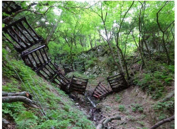
雪崩防止柵・・・小規模な落石にも有効
