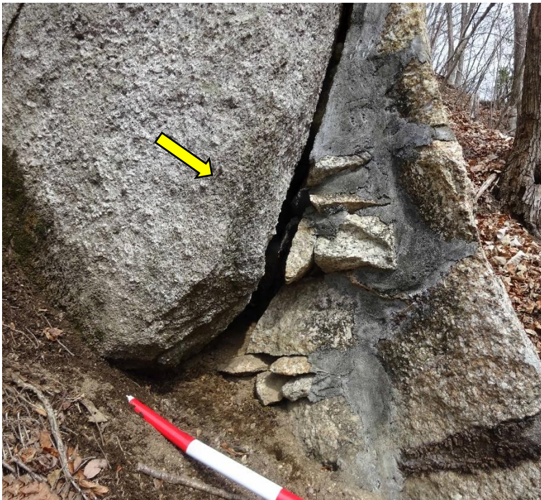
③根固工は主に転倒防止策であり、滑動対策にはなり難い！
