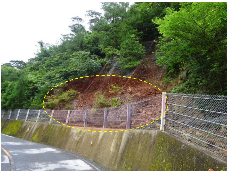
落石予防工（便覧 H29 年 12 月：区分改定）というよりは従来“防護工”区分が妥当！
