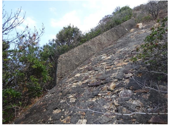
石張りによる発生源対策
