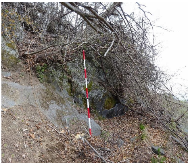
③終点側崩壊跡（モル吹付による復旧）
