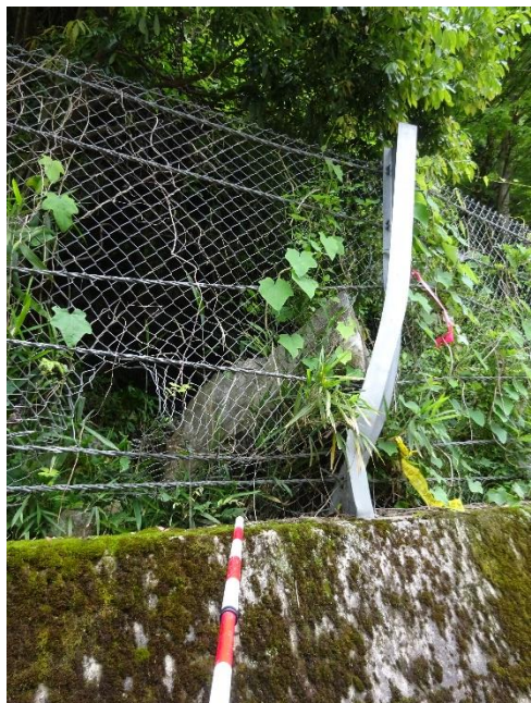
支柱の変形状況
