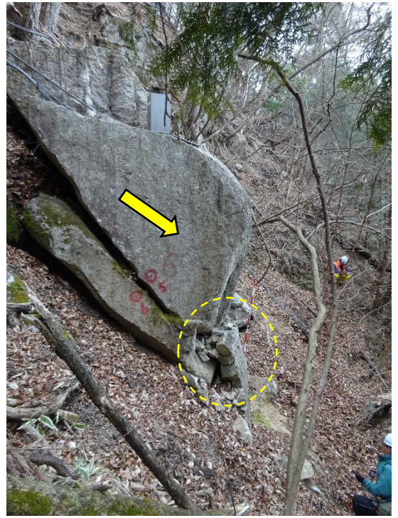
③根固工は主に転倒防止策であり、滑動対策にはなり難い！
