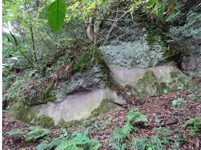
写真-3.2.15 根固工（モルタル吹付）
