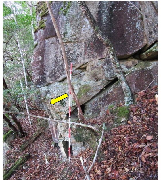
写真-3.2.24 バックリングによる剥離進行
