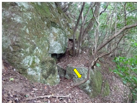
写真-3.2.11 局部的すべりによる退行性剥離
