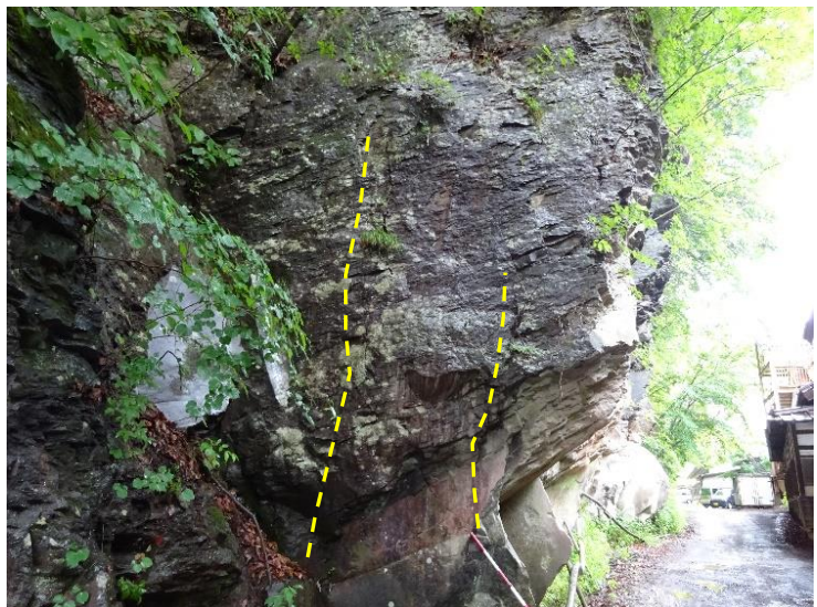
写真-3.2.16 オーバーハング箇所の 剥離進行状況
