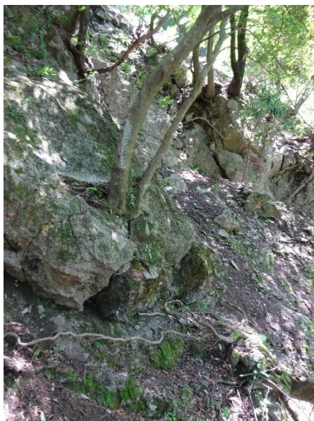
写真-3.2.12 旧崩壊地に残る浮石、転石
