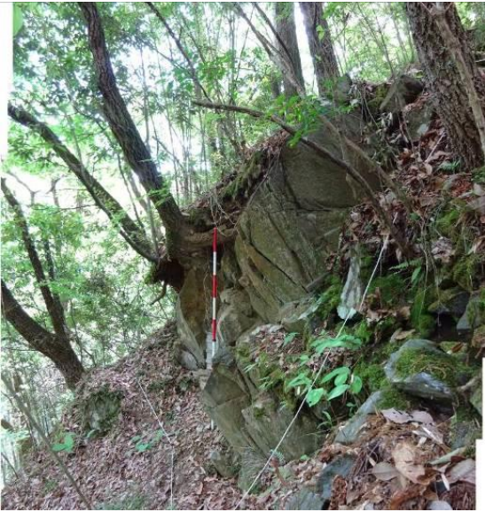
写真-3.2.18 トップリングによる崩落
