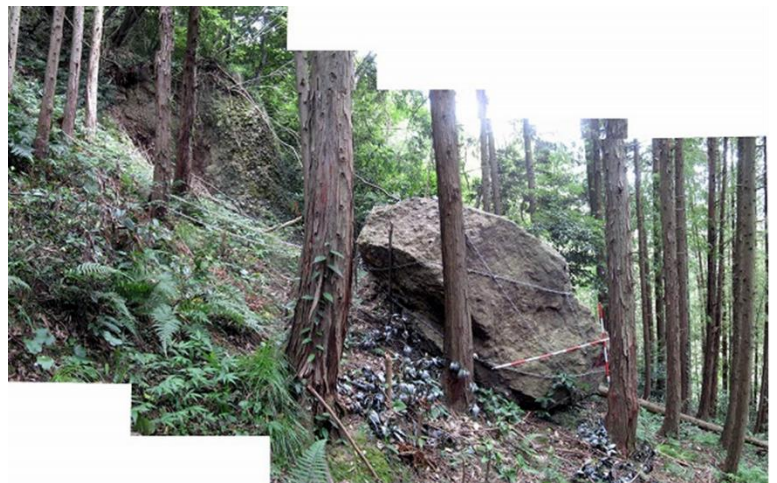
図2 20m 上部露岩から剥離し、転落した岩塊 岩塊が“滑り運動のみ”とすれば、さほど危険性を感じない
