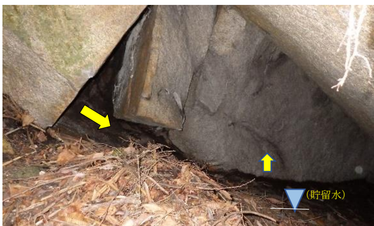
図 1.1 花崗岩の地すべり冠頭部陥没帯下流側側壁部 ※移動層がすべり面から局部的に浮いた状態，すべり面粘土なし
