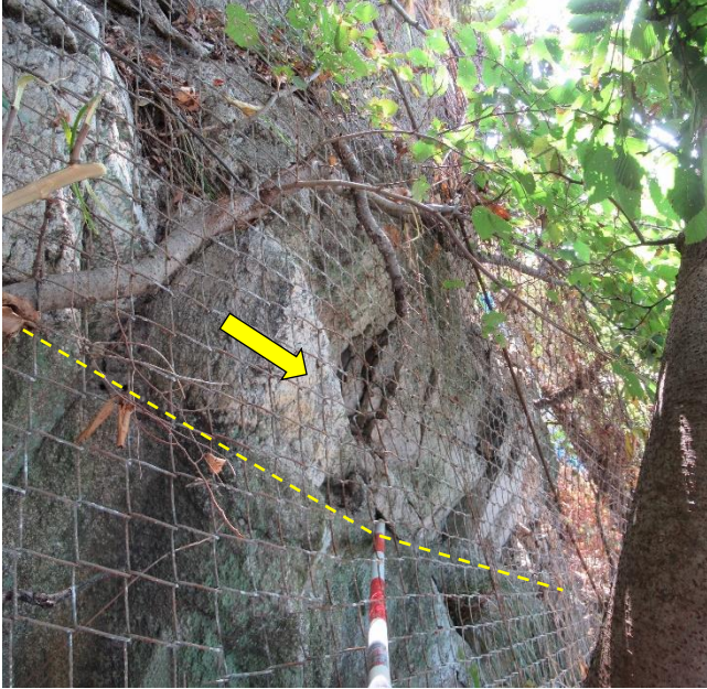
図 2.1 花崗岩のすべり面（右岸側側壁・・・谷部） ：数 cm 厚の白っぽい層（硬く，細粒）を介在し，これ の上位層が移動（層厚 4～5m. すべり面粘土と湧水なし）
