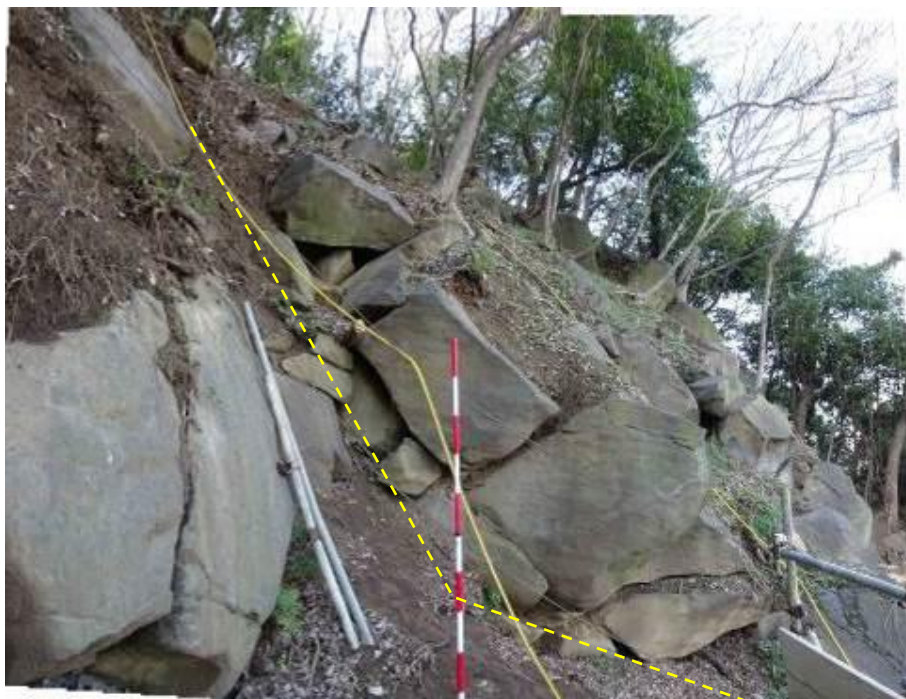
図 1.2 玄武岩（火砕岩）風化層内の板状すべり …冠頭部付近はルーズでややすべり面から浮いている
