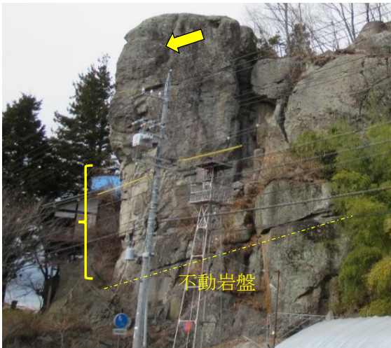
巨岩側面と剥離進行領域
