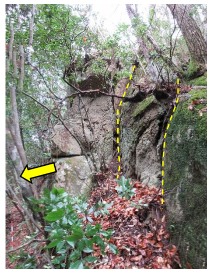
同左，左岸側側面
