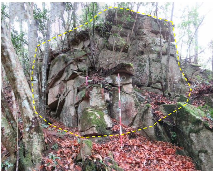
正面（岩盤崩落が想定される範囲）
