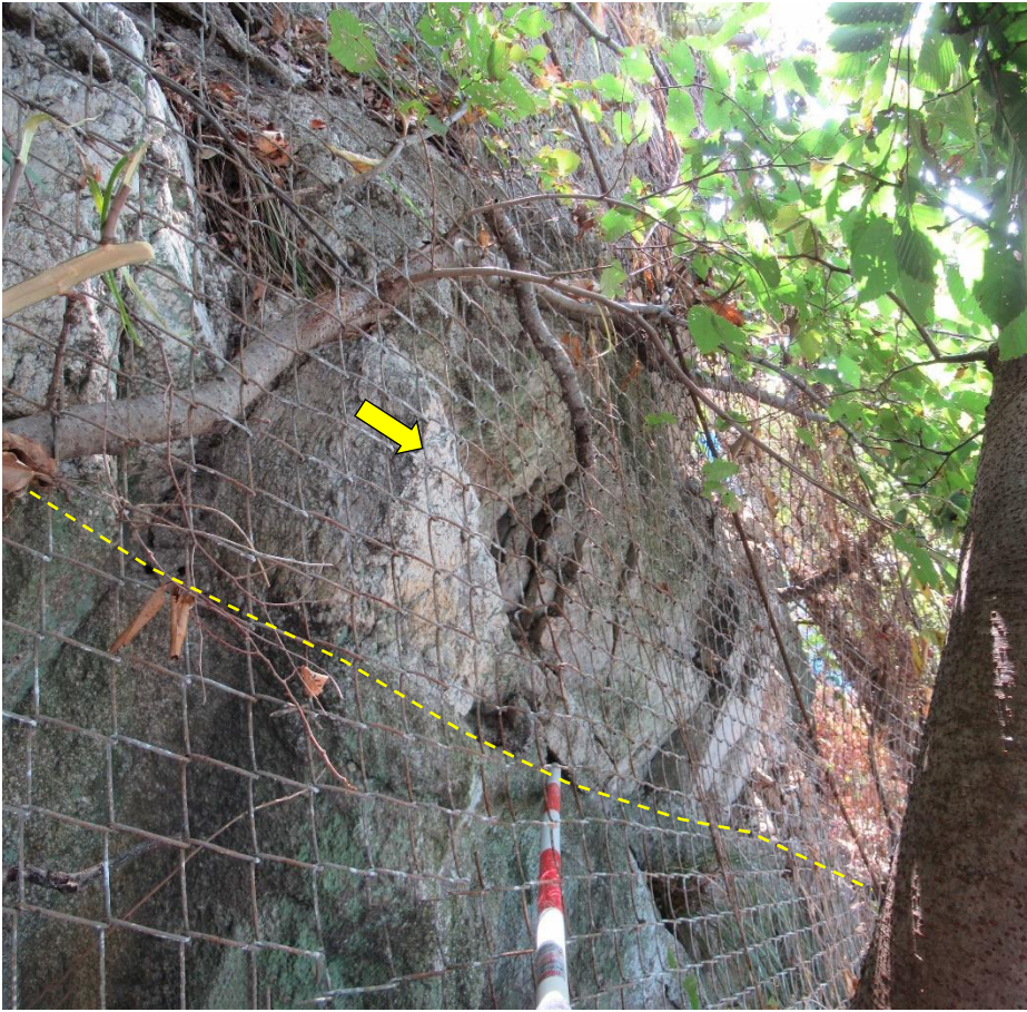
右岸側側壁部すべり面 (傾斜 45°, 粘土層や湧水なし)
