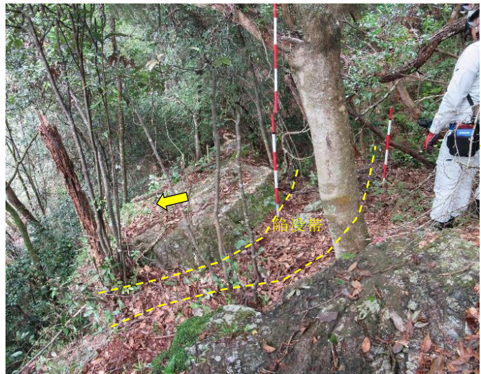
同左，頭部剥離状況
