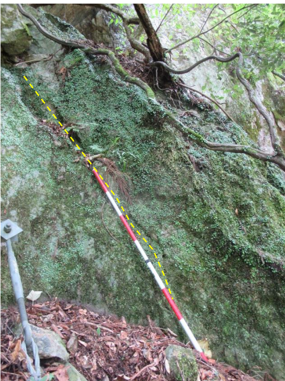
同上，右岸側：岩塊中位での，地表傾斜に沿った破断
