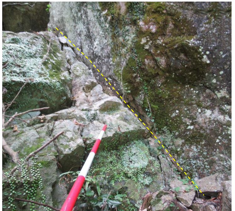
同左，左岸側（隣接露岩との接触部）
