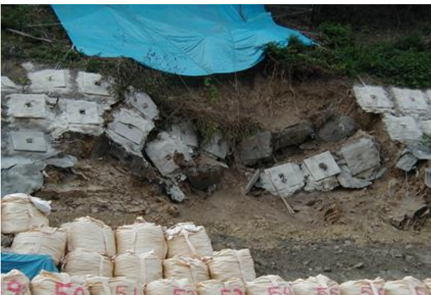
頭部連結効果（法面工で一体化下方が、抑止力が高い）
