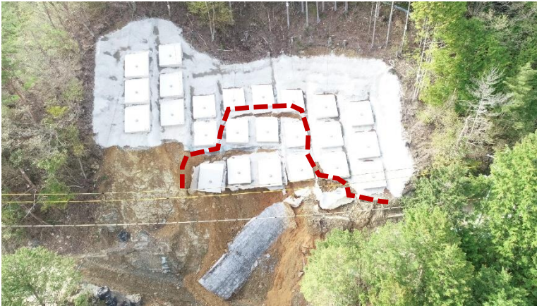
(層厚 3.5~4.5m の地すべりの場合：緊張荷重により地盤破壊した可能性が高いと思われる例)
