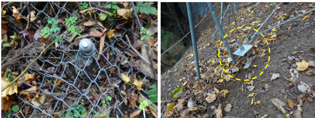
① 補強材の引き込み＝締付力発揮
