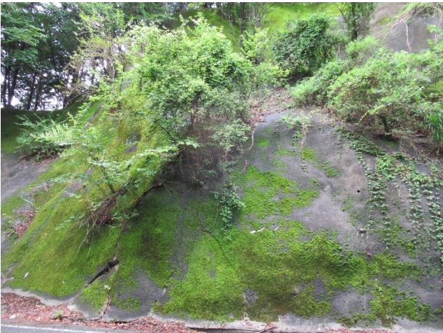
○吹付モルタルの水圧による剥離・・・普段湧水がなくても水抜きが必要
