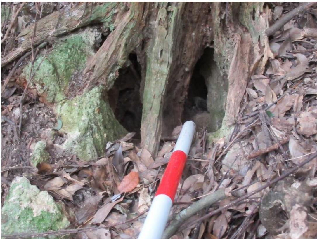
○地下水噴出孔（新第三紀砂岩）・・・表層崩壊滑落崖内
