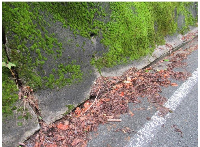
○吹付モルタルの水圧による剥離・・・普段湧水がなくても水抜きが必要
