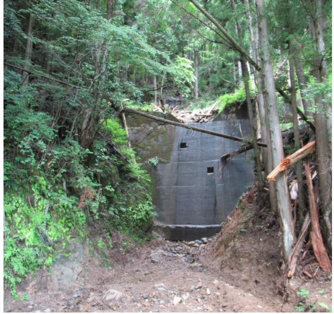
○吹付モルタルの水圧による剥離・・・普段湧水がなくても水抜きが必要
