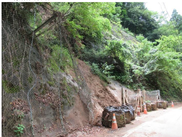
土石流による既設防護ネット，防護柵等の被災
