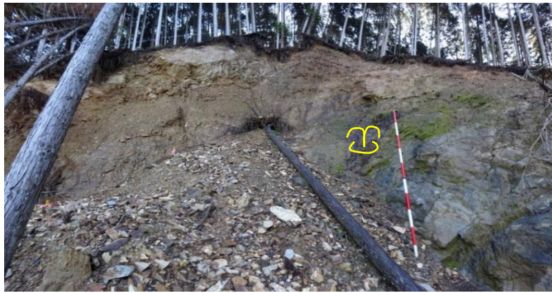
図 5.7 崩壊地頭部全景（幅 30～35m，斜面長 60m，層厚 5～7m）
