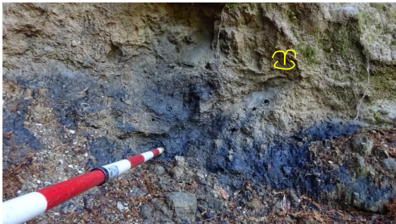
図 5.8 同上、拡大（パイプ状の空洞有り）
