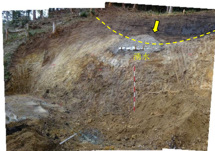
図 5.1 地すべり横断面のすべり面付近の湧水（泥岩）
