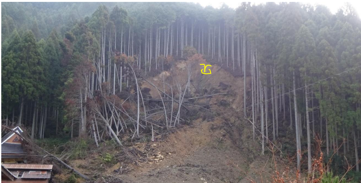
図 5.6 崩壊地全景（幅 30~35m, 斜面長 60m, 層厚 5~7m）
