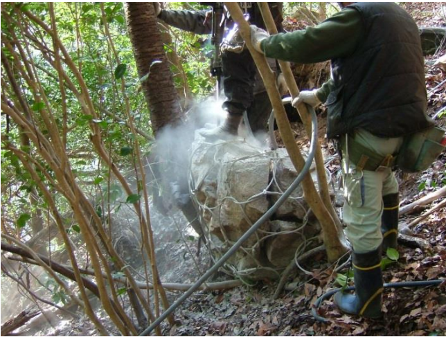
自在性の高いネットで巾着状に包んだ状態で小割りする（立木等によるアンカーで固定した状態）
