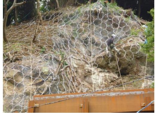
(崩壊性斜面の固定:ロープ足場施工)
