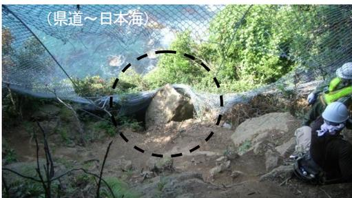
〔防護ネットを直撃した石をネットで巾着状に被覆し、小割整形後深層アンカーでそのまま固定〕
