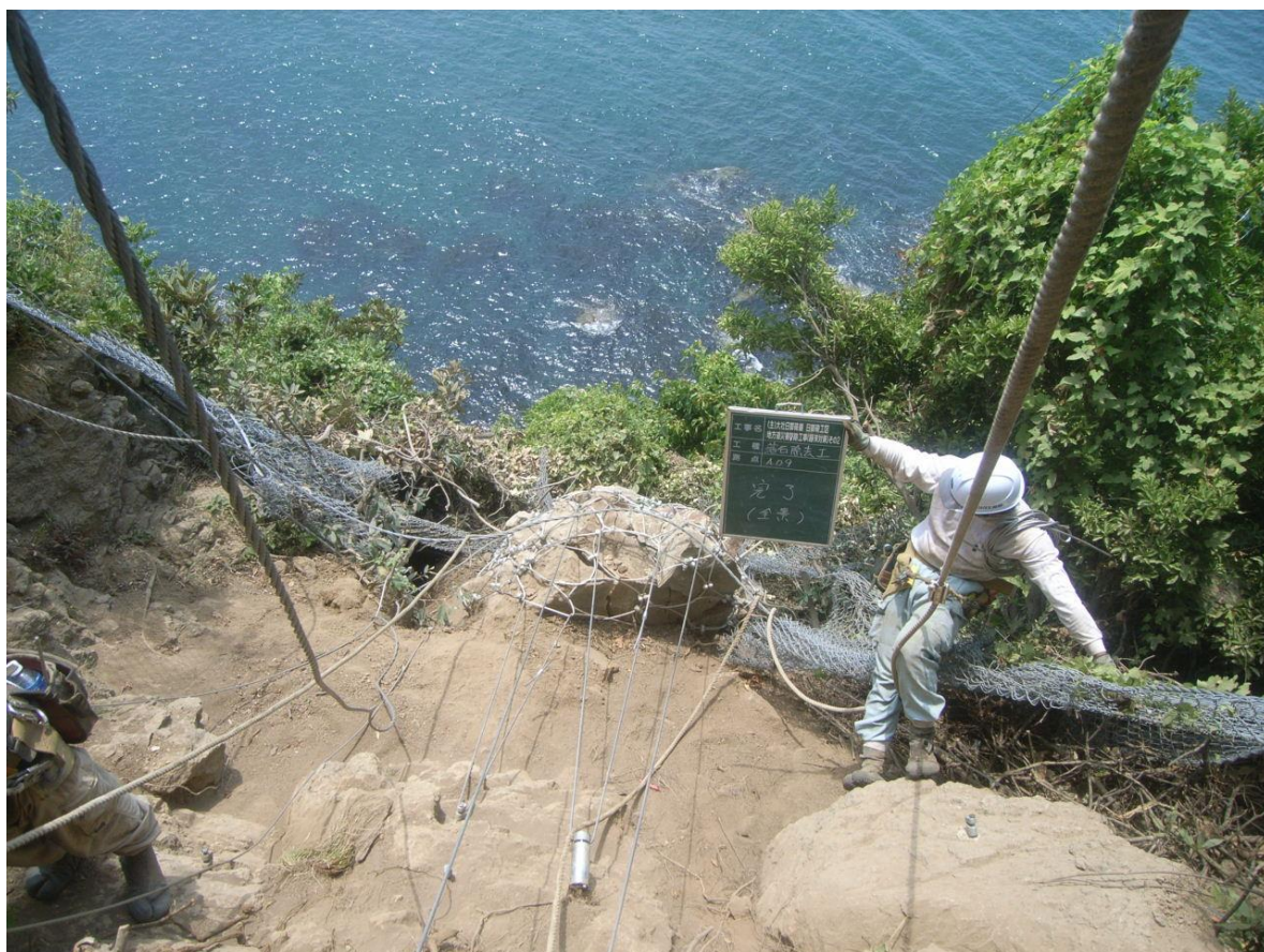
②防護ネットの上下からサンドイッチ状にワイヤーリングで包み、アンカーで固定
