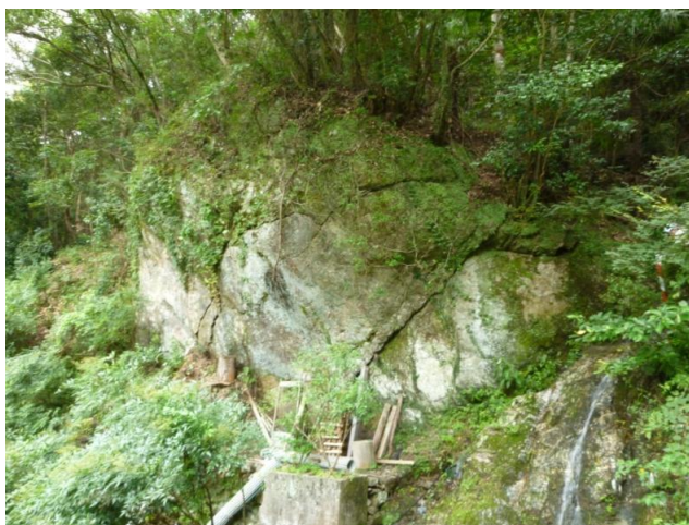
写真-7.3 滑動計算により“対策不要”とされた浮石 (割れ目に立木の根茎が進入し、浮石化を助長している)
